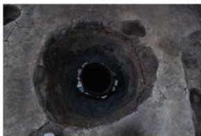
(13) 井戸 023 1段目 (北から)
