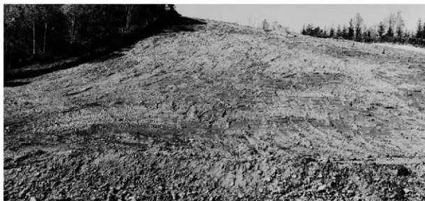
2 斜面部調査終了(南東から)
