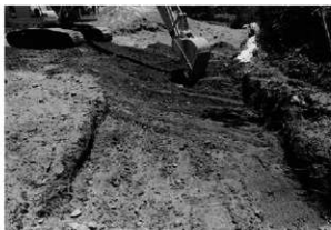
4 重機調査(中位部、南西から)
