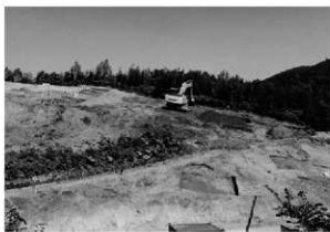
1 重機調査(斜面部、南東から)
