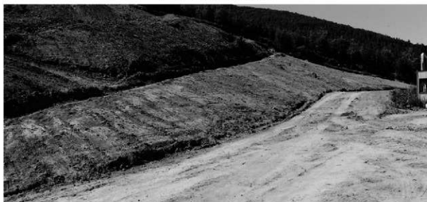
3 斜面部調査終了(南から)
