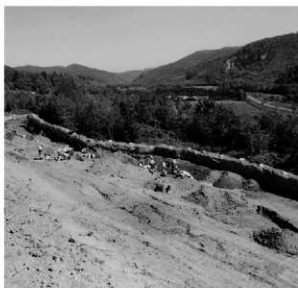
5 重機+人力調査(斜面部、南西から)
