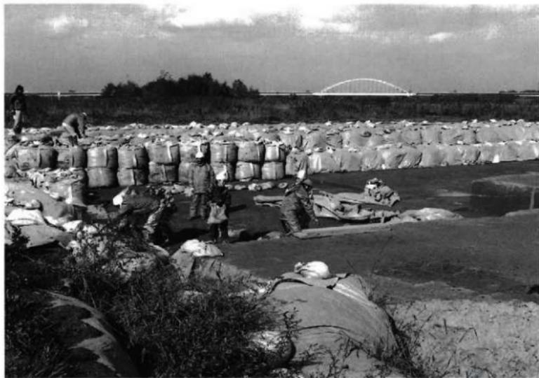
大型土嚢による壁面保護作業 S E → N W
