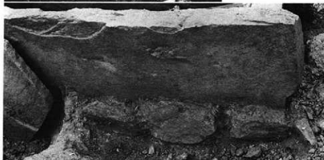
3.同上の上部裏込材を外した状態
