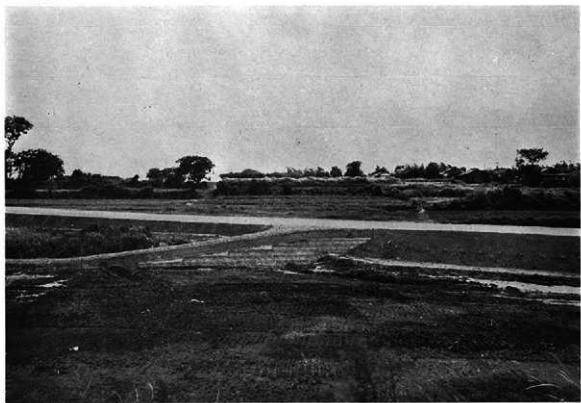
(2) 第2・第3地点遠景(西より)
