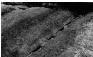
A1区SG5 (ベルト3～ベルト4) 路面半截状況 (東より)
