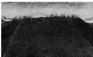
A2区SG8路面残存状況(東より)
