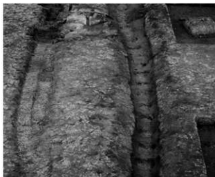
A 1 区最北部完掘状況（東より）
