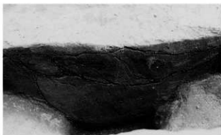
A1区SG5ビット3半截状況 (北より)
