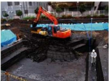
2. 重機による開削掘削状況（東から）
