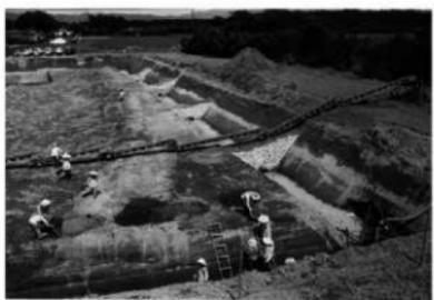
ベルトコンベアによる排土作業
