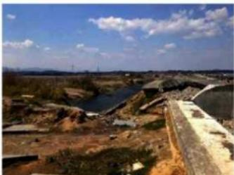
津波により破壊された防潮堤（南相馬市）
