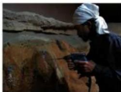
写真 45 アンカー穴穿孔
