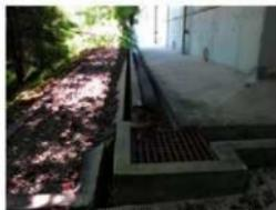
写真33 東側雨落ちと側溝の隙間
