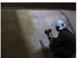
写真88 骨材吹き付け
