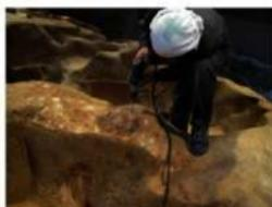
写真 43 水蒸気放出穴開け
