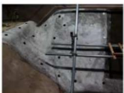
写真85 プラスチックアンカー設置
