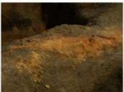
写真 21 表層の剥落
