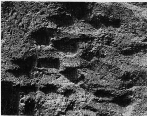
1 道田1号墳墓壁面工具使用痕D
