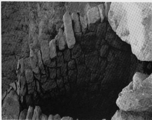
1 原口1号墳玄室左側壁
