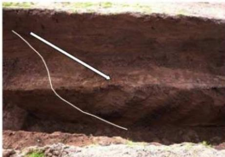
図55 遺物包含層を含む地層の円弧すべり
