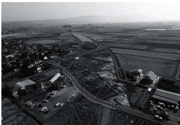
3 2次調査区全景（1）（北西から）
