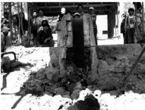
写真10 炉解体のようす
