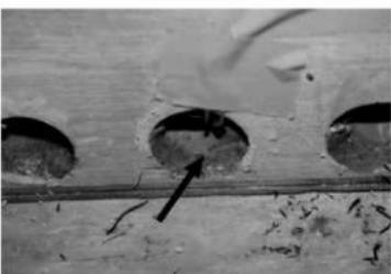
写真 5 風箱内のセンサ設置状況
