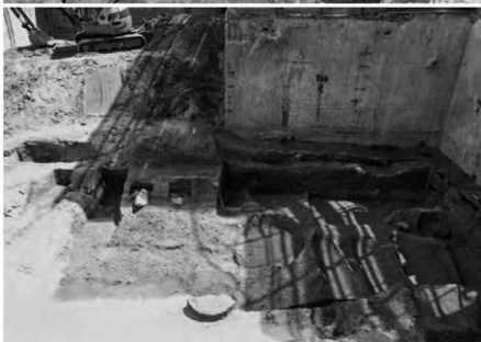
西区 第9層上面遺構 掘削状況(西から)
