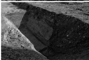
拡張区(1) 掘削状況 (北西から)
