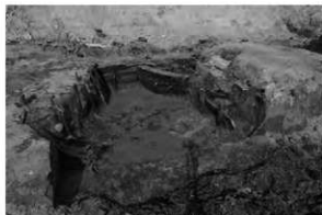
写真4 SX08掘削状況(南から)
