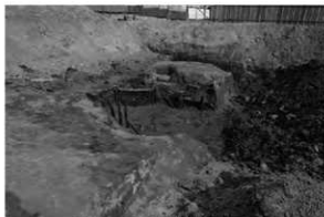
写真3 SX08掘削状況(西から)
