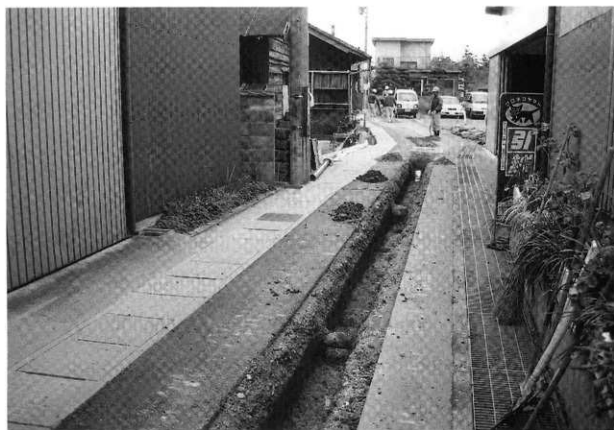
第134-8次 調査区近景（西から）
