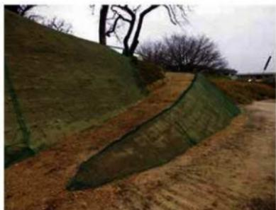
図 5-44 土壌上部への動線確保（スロープの設置）
