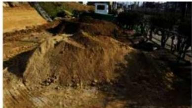
図 5-38 土壌復元に用いた土材の一部（手前から山土、河川堆積物）
