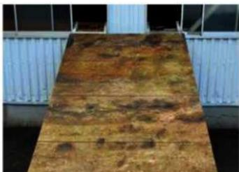
図資 3-14 弹性接着剤を下地に塗布し、陶板を固定
