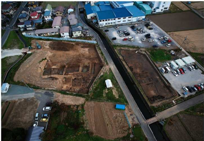
1区・2区空中写真 2016年11月撮影
