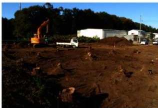
重機表土剥ぎ
