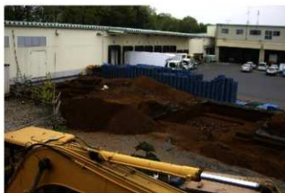
完掘 (南西から)
