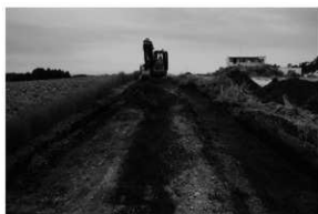
作業風景 I 1-107 付近 表土除去 東から
