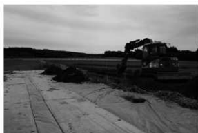
作業風景 I 1-103 付近 表土除去 西から
