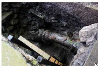
①J-22区 石垣に残された砲弾・銃弾痕 ②J-22区 砲弾痕と内部の金属 ③J-22-23区 御樓門部排水溝遺物出土状況 ④L-25区 排水溝内出土銃弾 ⑤L-21区 鑄鉄管、排水溝等 ⑥N-21区 鑄鉄管 ⑦N-21区 石畳下（漆喰面下）の鑄鉄管、石垣裏込石、⑧K-21区 鑄鉄管周りの状況
