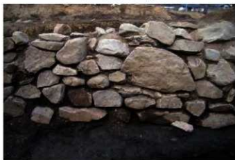
3・4面 石積A⑤(南から)
