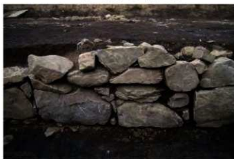
3・4面 石積A③(南から)
