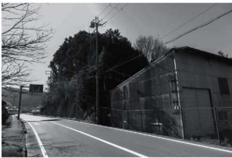
1 調査地遠景（北から）
