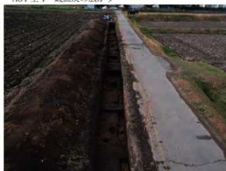
A4T 完掘東から
