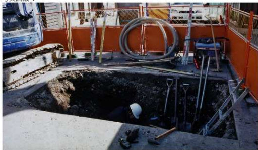
西外堀トレンチ2 全景 (北から)
