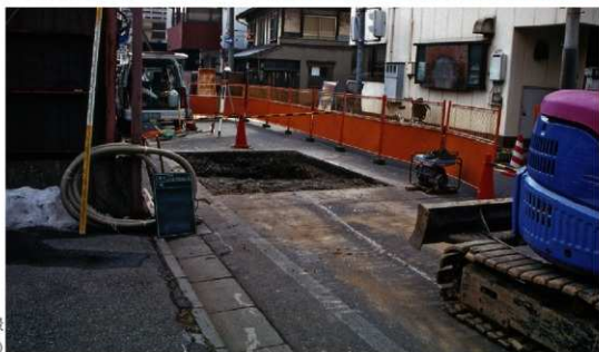
西外堀トレンチ1 全景 (北から)
