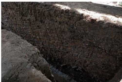
南外堀トレンチD 西側壁面 (北東から)
