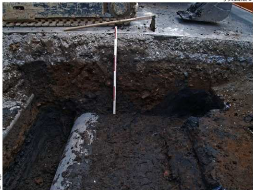
西外堀トレンチ3 全景 (北から)
