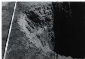
01SX 完掘状況
