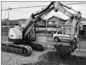
重機掘削状況
