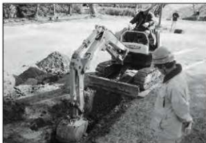
重機掘削状況
