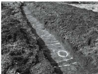
2 トレンチ完掘状況
