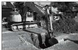
重機掘削状況
