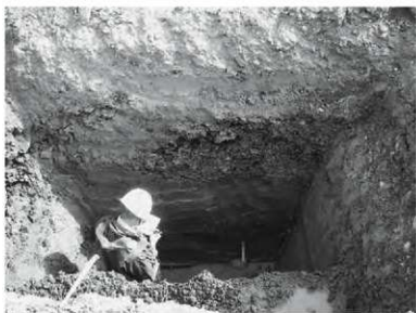
試掘坑3 記録作業状況
