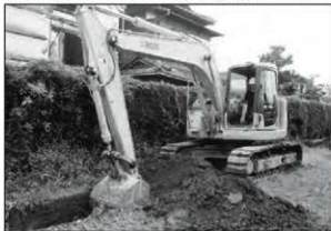
重機掘削状況
