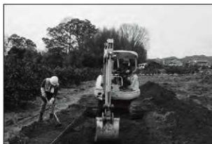
重機掘削状況
