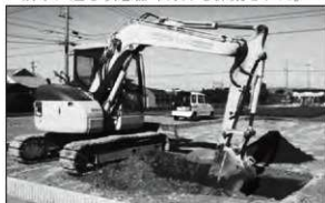
重機掘削状況
