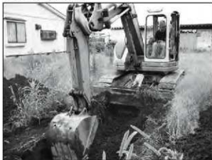
重機掘削状況
