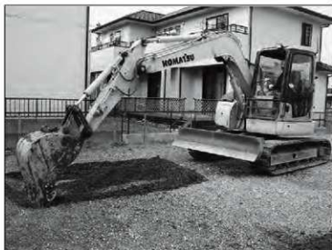
重機掘削状況
