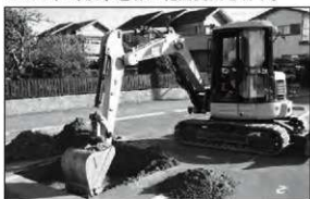
重機掘削状況
