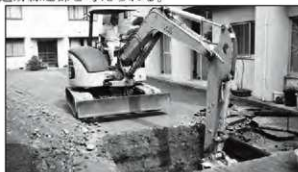
重機掘削状況
