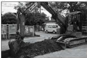
重機掘削状況
