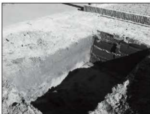
完掘状況(試掘坑4)
