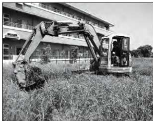
重機掘削状況
