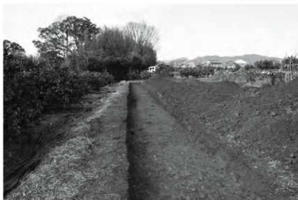
1 トレンチ完掘状況
