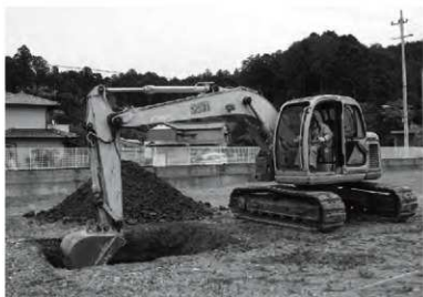
重機掘削状況
