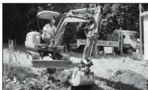
重機掘削状況
