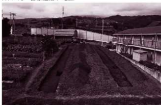
1. 調査地全景 (南から)
