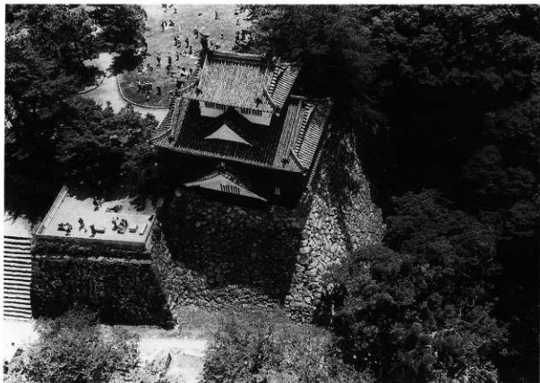
1. 鉄櫓下石垣全景-1(北から)
