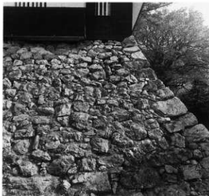
1. 北面石垣出隅部上半(北から)
