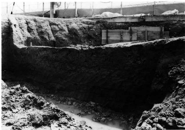
2. 断ち割り状況(北西から)
