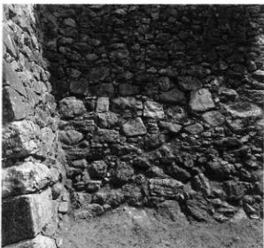
3. 北面石垣と武具庫下石垣(北から)
