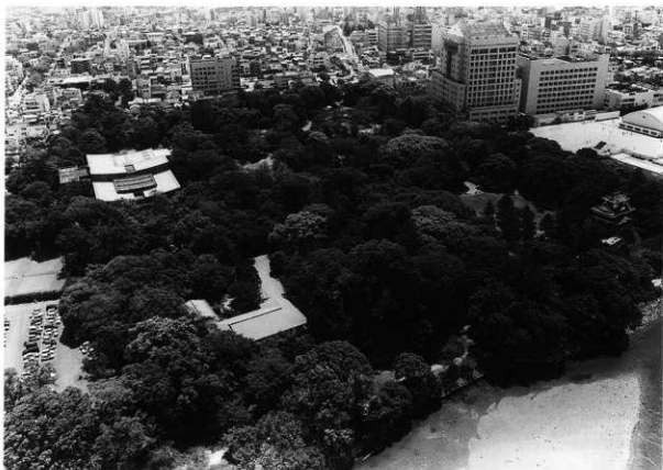
2. 本丸・二の丸の現状-2(北東から)
