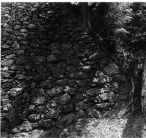
6. 西面石垣南端(西から)
