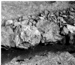
3. 石積みの様子 (西から)
