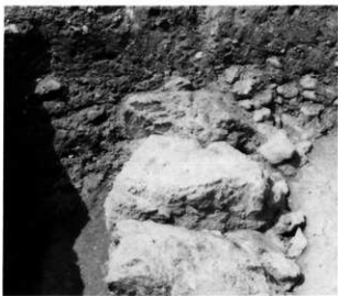
4. 石垣埋没状況 (南から)
