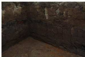
写真8 1T堆積状況(L・Mライン)
