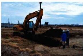
写真3 表土掘削状況
