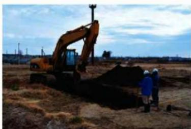
写真3 表土掘削状況
