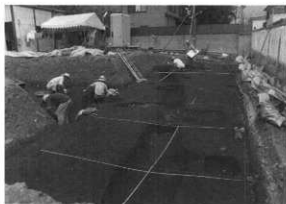
図31 作業風景（西から）
