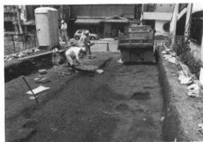
図11 作業風景（南から）
