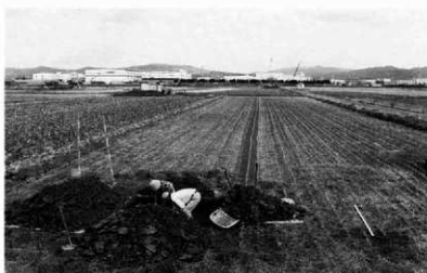
19トレンチ調査風景(西から)
