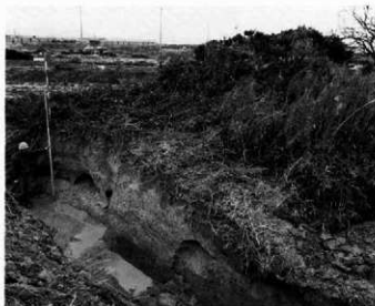
34トレンチ（堤防断ち割り）
