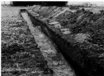
50トレンチ(南から)
