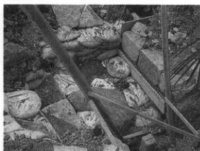
図30 南階段保護の状況（南から）
