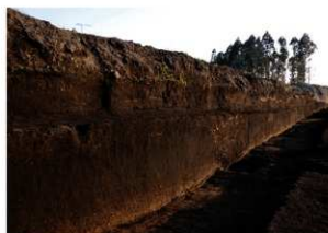
第2次調査区東側土層断面（北から）
