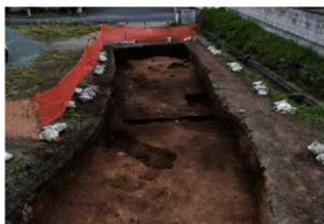
SK-3周辺全景 (北方から)
