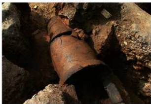
東煙道土管検出状況（東から）
