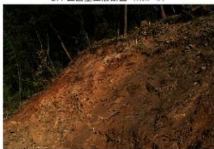
ZU6区北壁土層断面 (南から)
