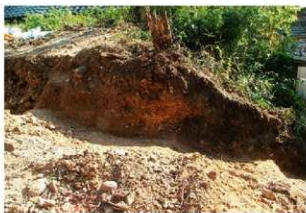
A7・Z27区南壁土層断面 (北から)
