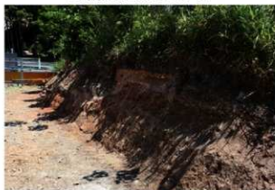
立会調査範囲断面 (北西から)
