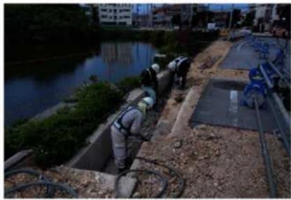
7. コンクリート製暗渠の除去作業状況
