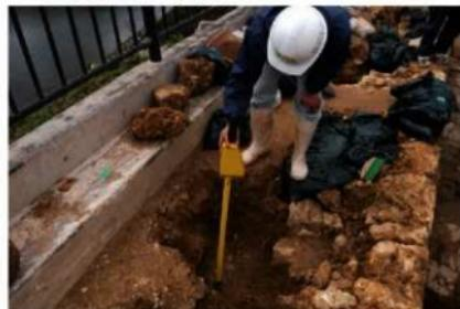
6. サブトレンチ掘削前の不発弾等確認のための磁気探査
