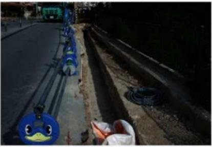
8. コンクリート製暗渠除去後の水路構造
