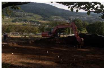
XI次 重機掘削
