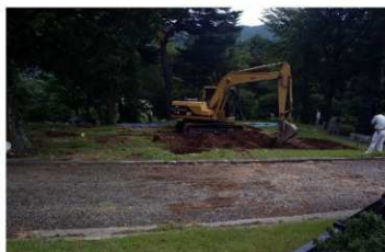
XII次 重機掘削
