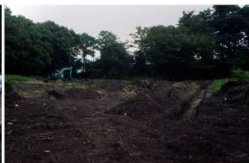
XIII次 トレンチ掘削
