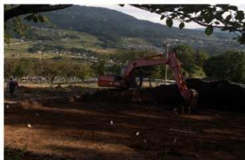
XI次 重機掘削
