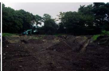
XIII次 トレンチ掘削
