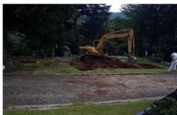
XII次 重機掘削
