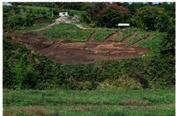
遠景 (南東から)
