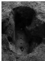
TP-316完掘状況(北西から)
