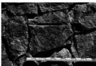
写真6 発破孔のある石材
