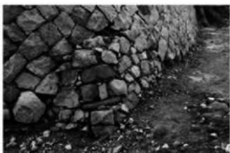
写真7 下流側巻石先端基底部の石積み
