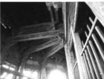
第27図 応県木塔の二重内部の構造
