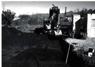
H1号住居址検出状況
