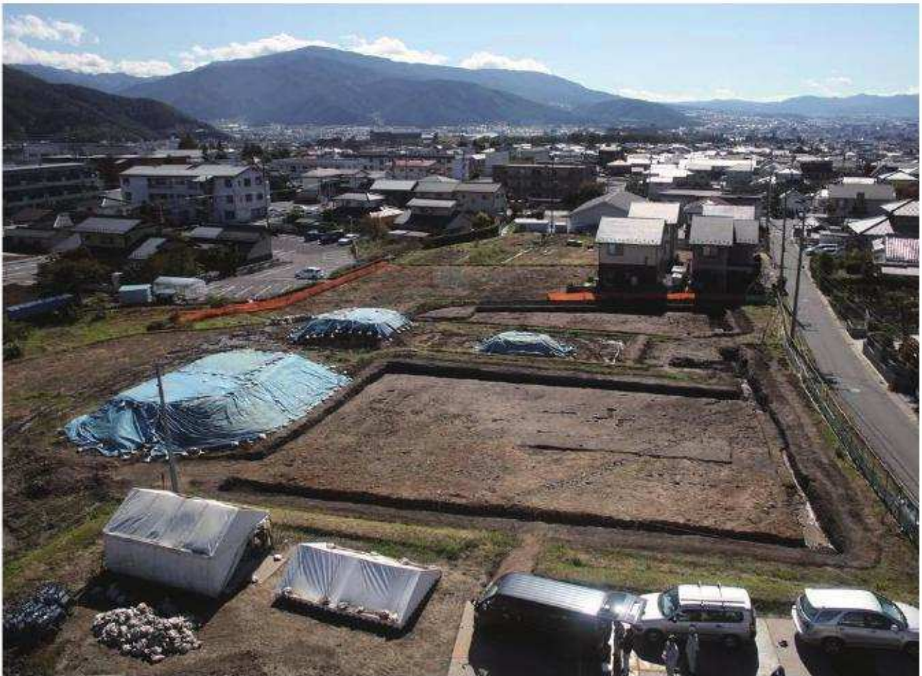
調査地遠景 (北西から)
