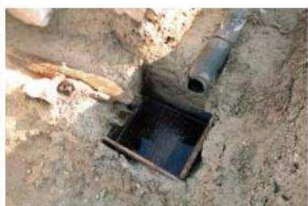
写真60 道路下の配水管から木樋への分岐点
