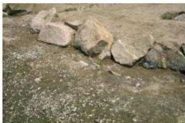
写真47 大形花崗岩による護岸
