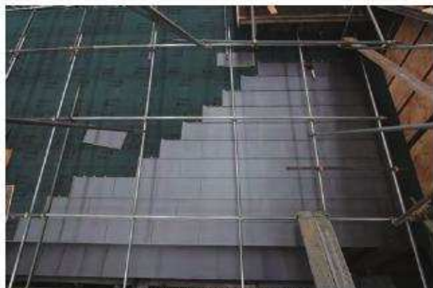
ガルバリウム鋼板葺施工状況
