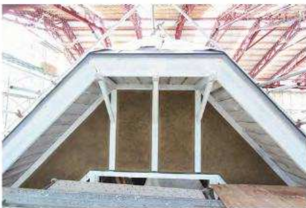
掃付けモルタル壁施工完了「南棟」妻面
