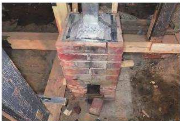
煙突補強鋼管とプレート施工状況
