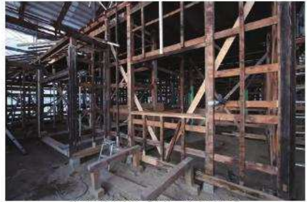
壁下地組立完了「南棟」南東よりみる
