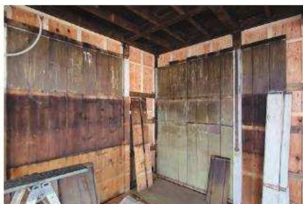
化粧板施工状況 居間 南東よりみる
