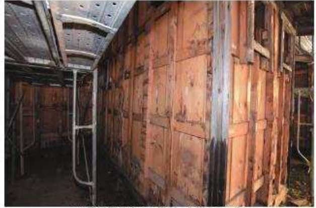
下見板解体完了 便所 北西よりみる
