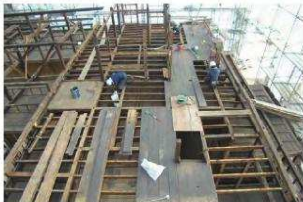
床板解体状況 二階 西よりみる
