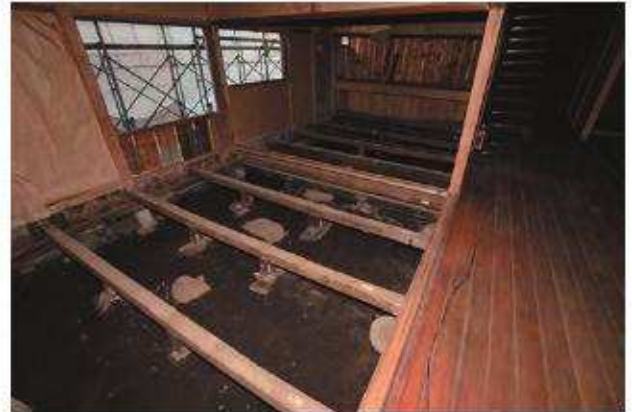
大引 客室1、2 南東よりみる
