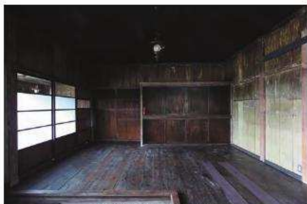
【竣工】居間 東よりみる
