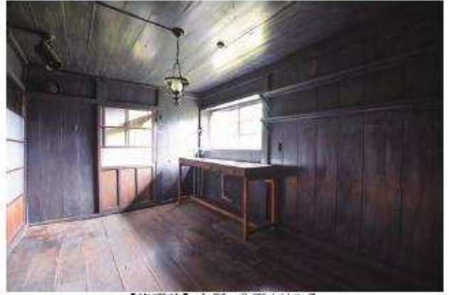
【修理前】台所 北西よりみる
