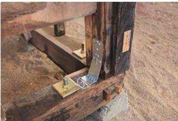
補強金物設置状況
