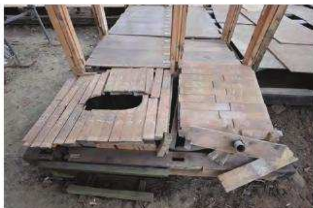
後設化粧床板 便所 西よりみる
