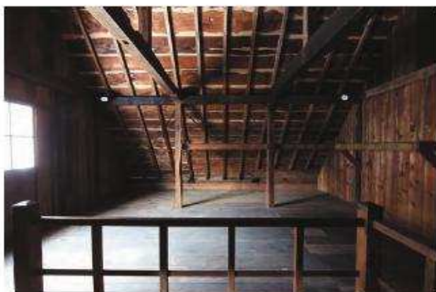
【竣工】小屋裏物置 南よりみる
