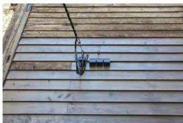
引込設備施工完了
