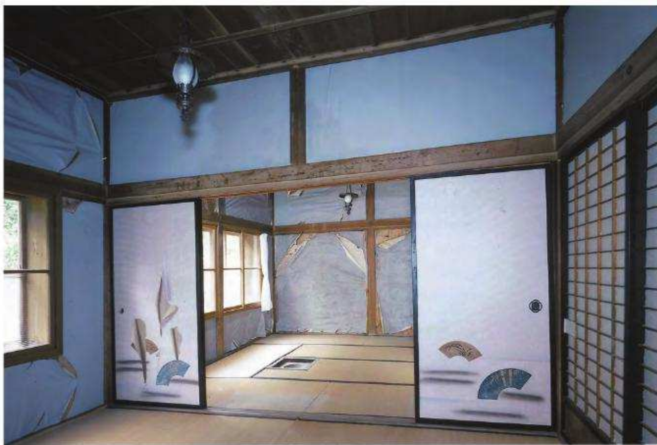
【修理前】 客室 3 南東より客室 4 を見通す
