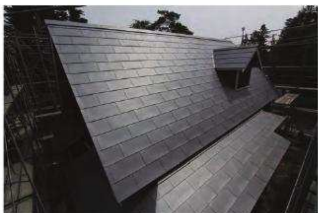
鋼板葺完了「南棟」南西よりみる
