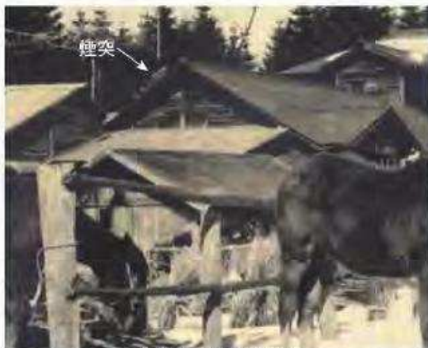
図3-3-8 Ⅲ期の建物南面 前身建物本家の表面が写り梁間寸法や屋根形状が判明する。玄関背面側に煙突が見え、この付近に台所があったとみられる。
