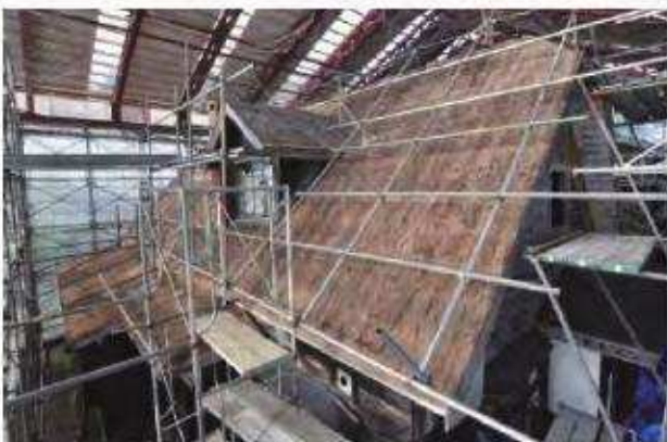
写 3-5-14 「南棟」下葺とした桁葺
