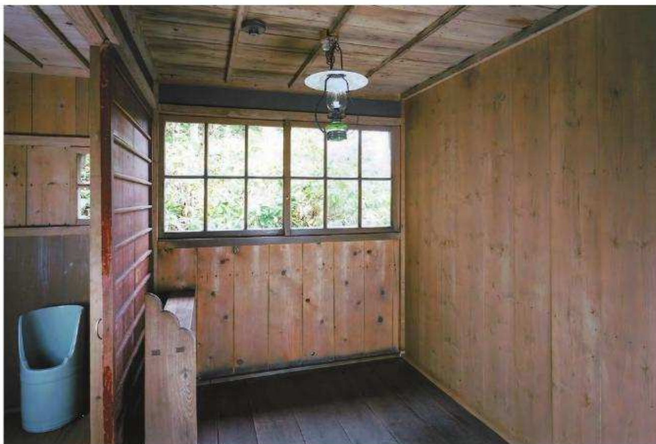
【竣工】洗面所 南西よりみる
