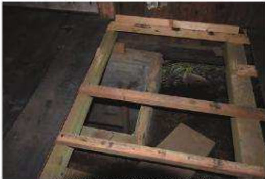
床下に遺存していたムロの開口部
