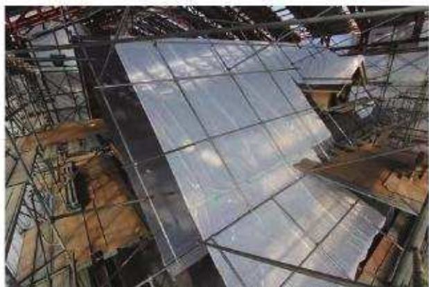
屋根養生状況「南棟」南西よりみる
