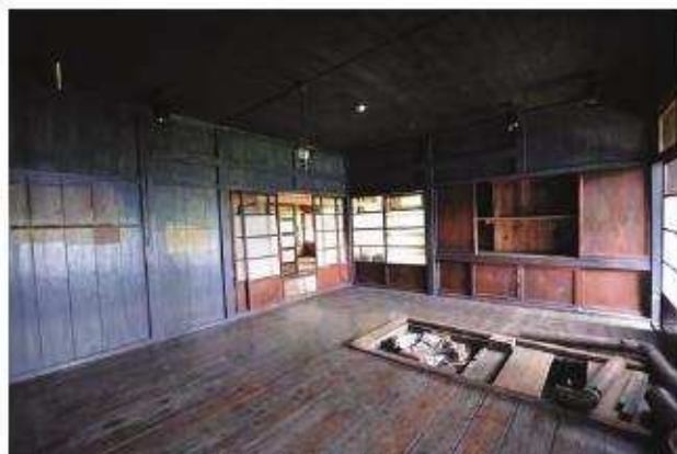
【修理前】居間 南西よりみる
