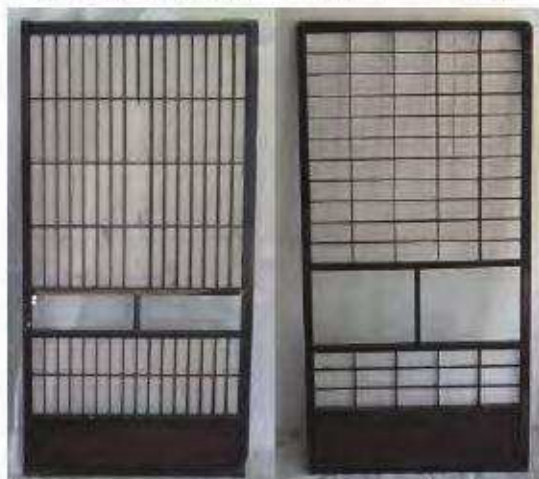
ランプ室前 腰付額入整繁障子 組子丸面取 ランプ室・便所境 腰付額入横組障子 組子角面取
