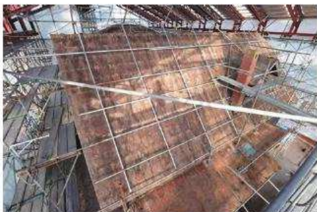
鋼板葺解体完了 桁葺
