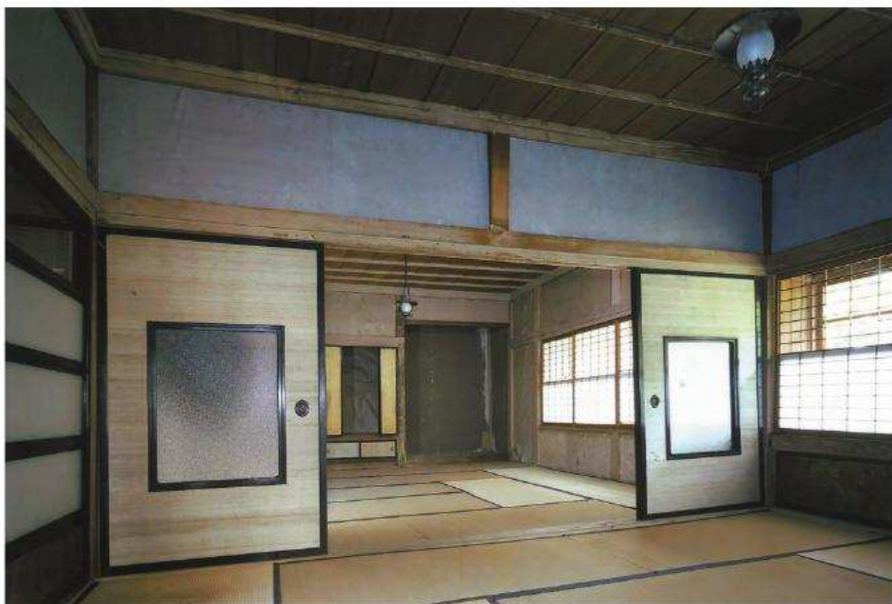
【修理前】茶の間南西より仏間を見通す
