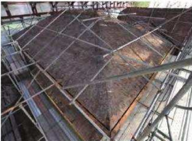
写 3-5-12 「北棟」鉄板下に遺存していた桁葺
