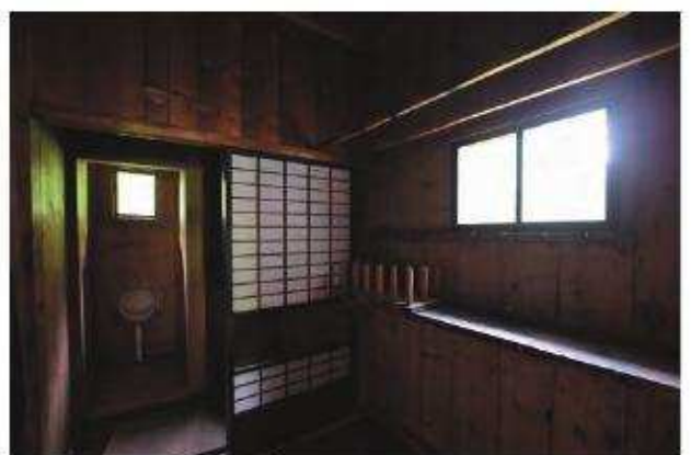
【修理前】ランプ室より「南棟」便所を見通す
