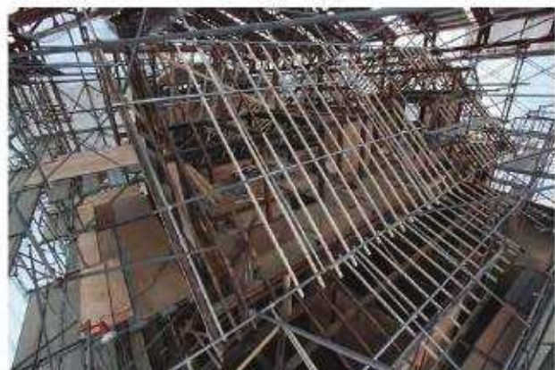
垂木組立完了「南棟」南西よりみる
