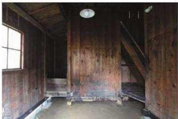
【竣工】 物置 南よりみる
