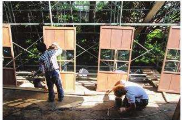
建具古色塗り状況
