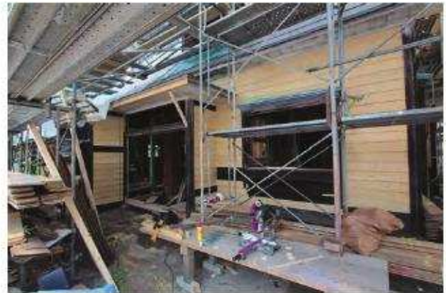
下見板張り施工完了「南棟」南東よりみる
