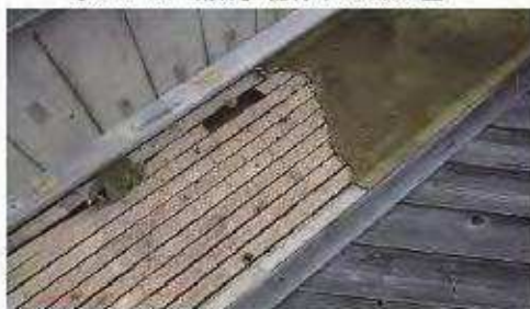
写 3-5-20 同上解体時状況
