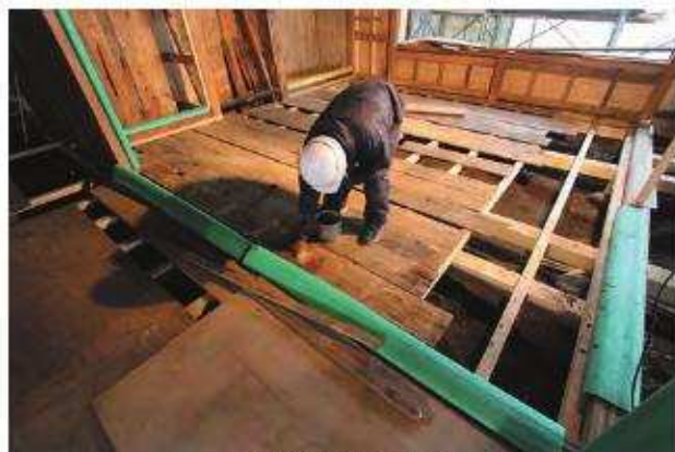
荒床施工状況 仏間
