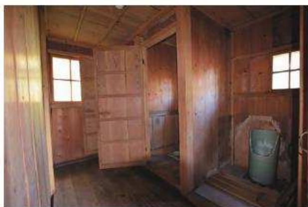
【修理前】「北棟」便所 南東よりみる
