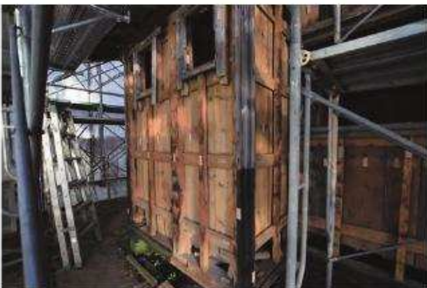
下見板解体完了 便所 南西よりみる
