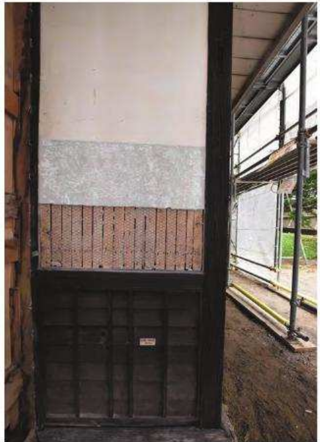
壁面層出し 玄関外廊壁 南面
