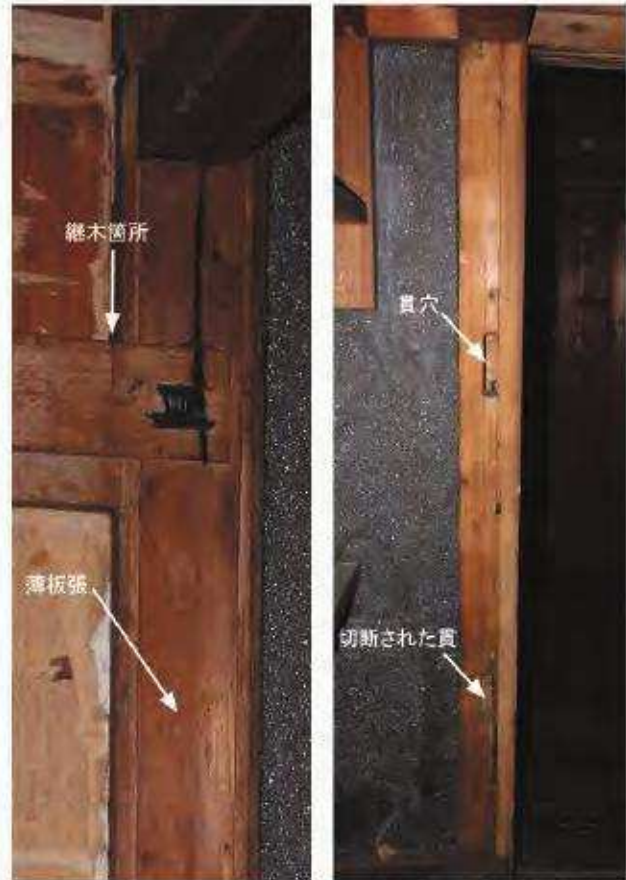
トコ長押の継木（北西角柱）
