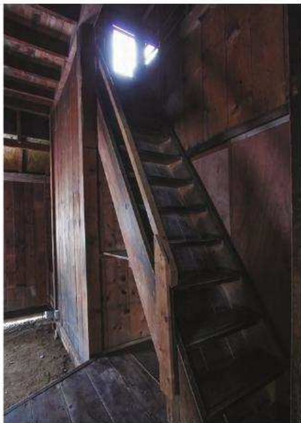
【竣工】「南棟」階段 南東よりみる
