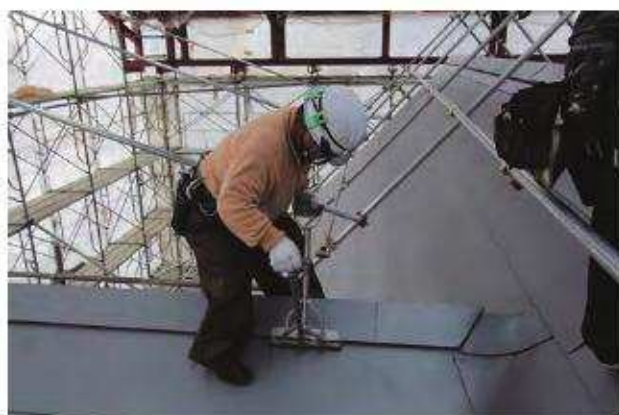
棟包み施工状況
