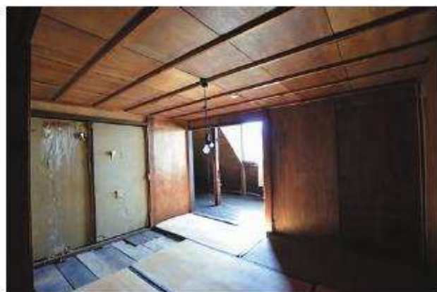
【修理前】和室1 北西よりみる
