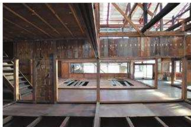
紙貼解体完了 客室1、客室2西よりみる
