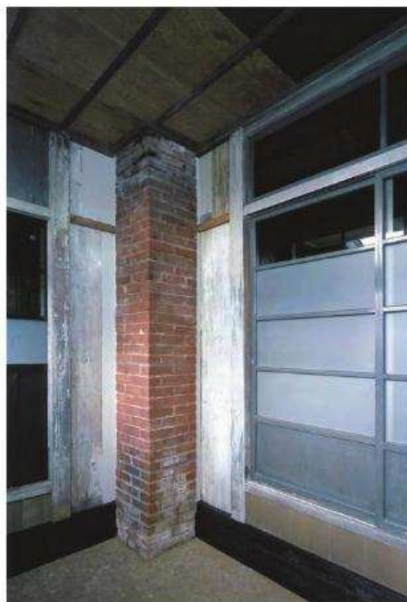
【竣工】裏玄関煙突
