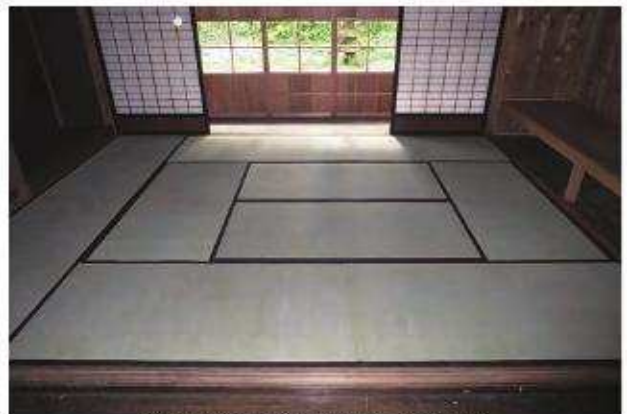
畳施工完了「北棟」客室5 西よりみる
