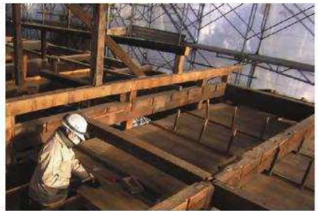
天井解体状況「南棟」廊下 南西よりみる
