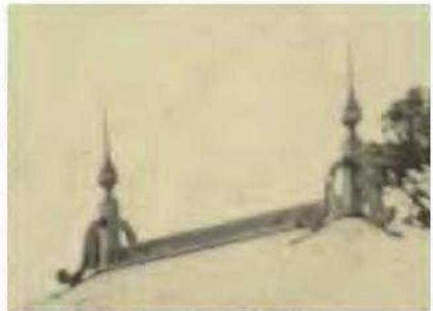
大正9-昭和5年の棟飾り詳細 やや写りが不鮮明であるが、蕨手状の脚部が確認できる。
