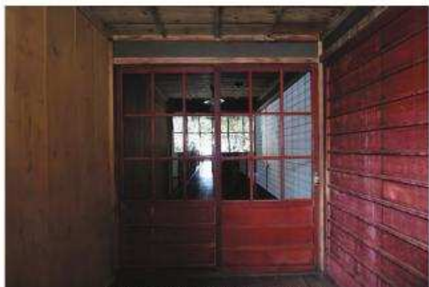
【竣工】「北棟」洗面所 北よりみる
