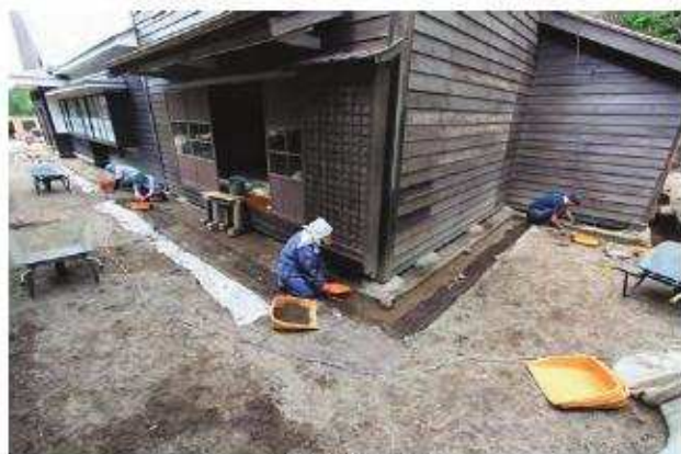
雨落溝発掘状況
