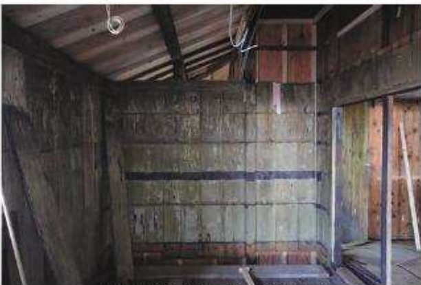
化粧板壁施工状況 台所 東よりみる
