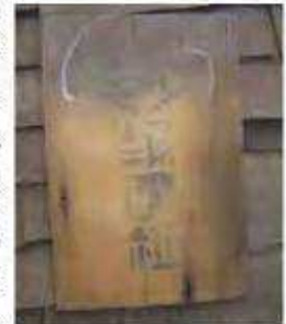
写 3-5-16 桁板の印字 ＜報国桁＞（昭和16年）
