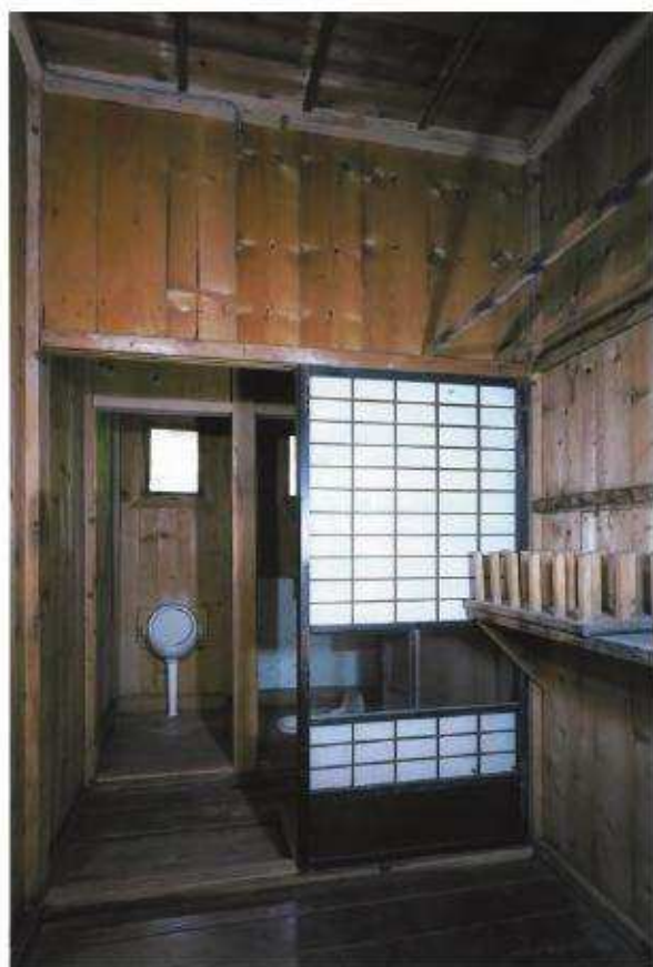
【修理前】ランプ室より便所を見通す
