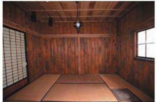
【修理前】客室6 北よりみる
