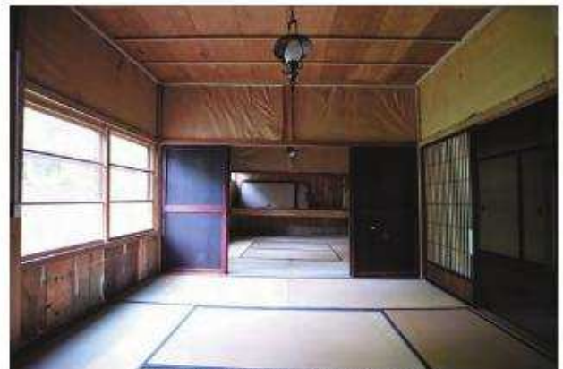
【修理前】客室1より客室2を見通す
