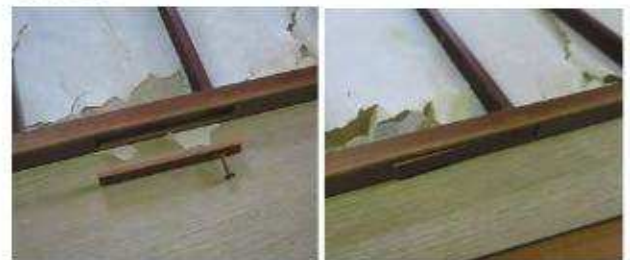
写 3-5-26 摺り上げ障子の機構
