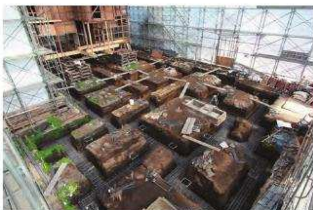
基礎配筋状況 南西よりみる
