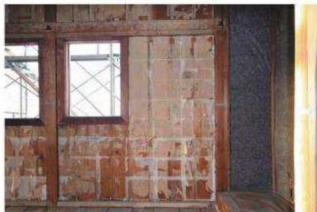
後設化粧板解体完了 客室7西面
