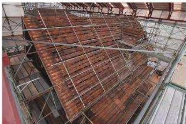
桁葺解体完了 野地板
