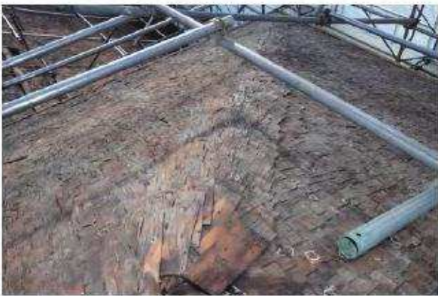
遺存していた桁葺の隅棟
