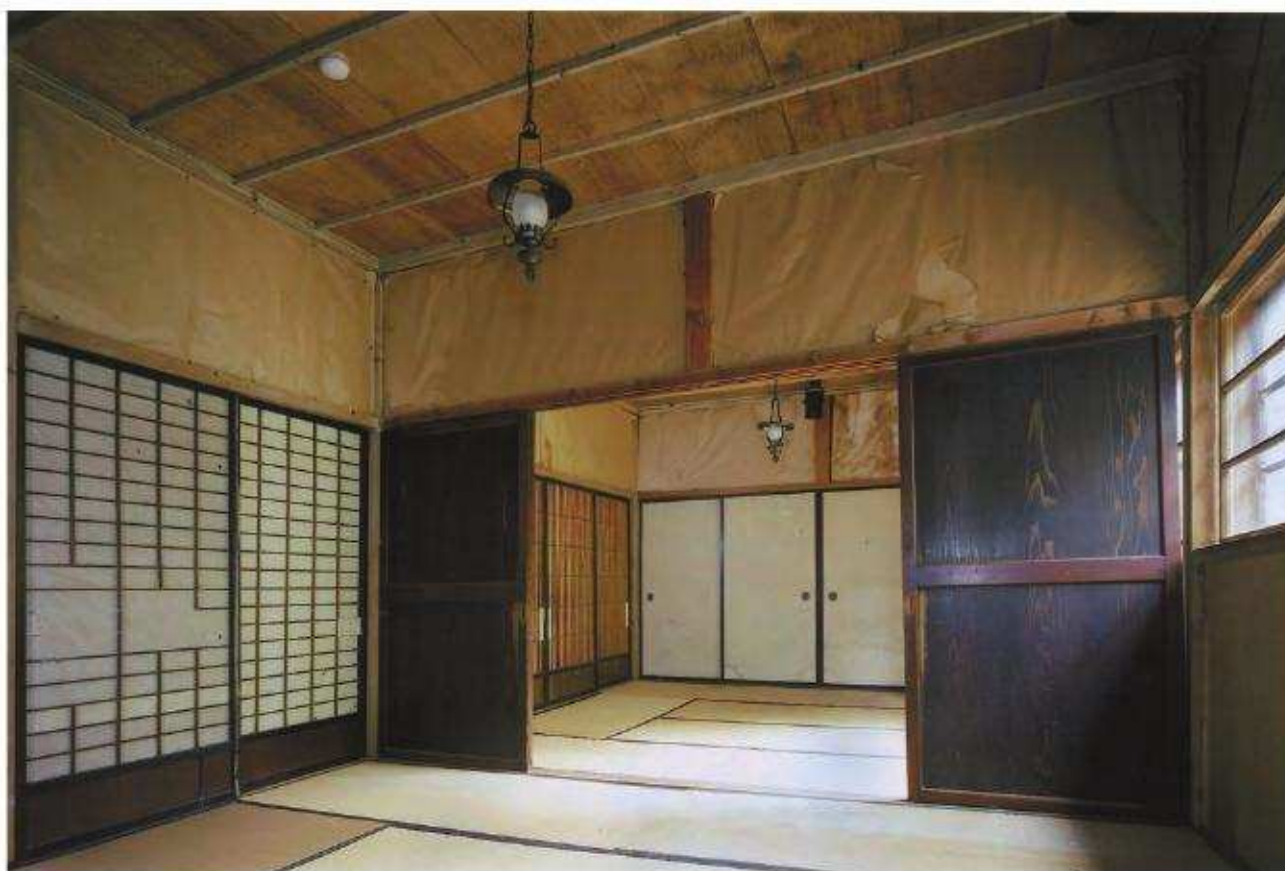
【修理前】 客室2 北西より客室1を見通す
