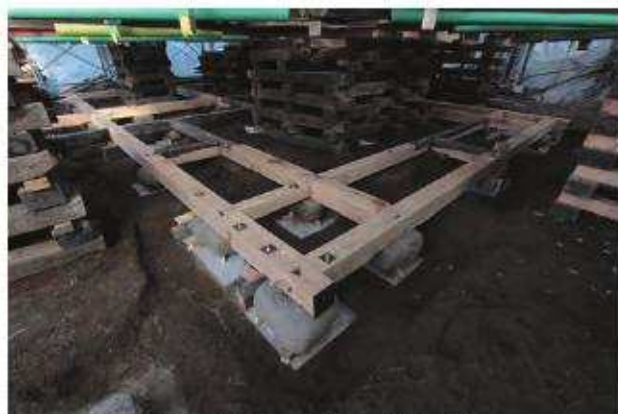
土台組立完了「北棟」南東よりみる
