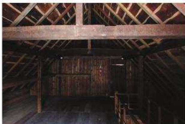
【竣工】小屋裏物置 西よりみる
