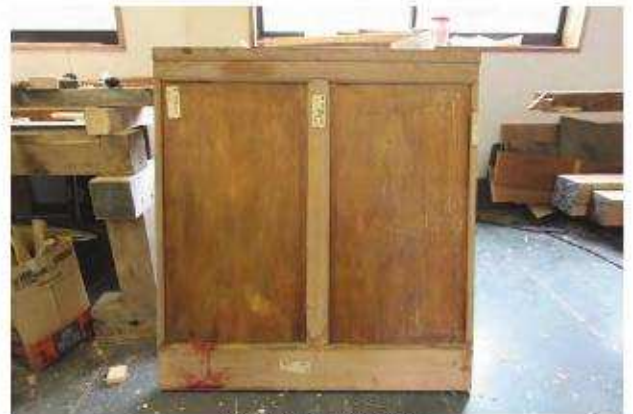
仮組状況 事務所腰板
