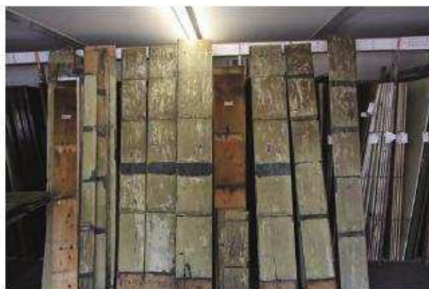
既存塗膜剥離状況 台所化粧板
