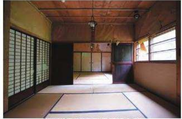
【修理前】客室2より客室1を見通す
