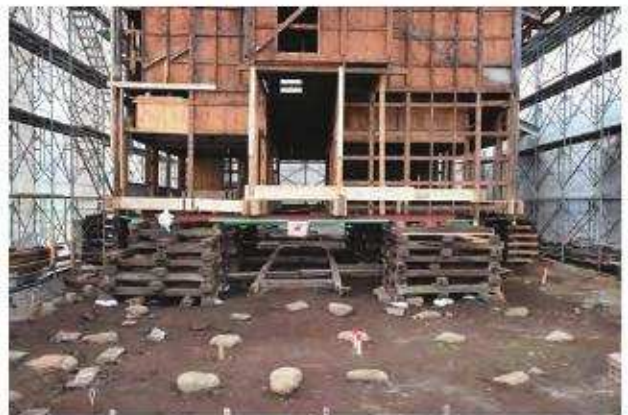
ジャッキアップ完了 (1.5 m)
