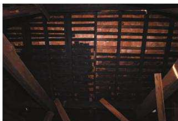
小屋裏 野地東面をみる
