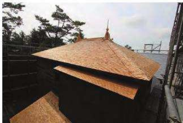
葺葺施工完了「北棟」北西よりみる
