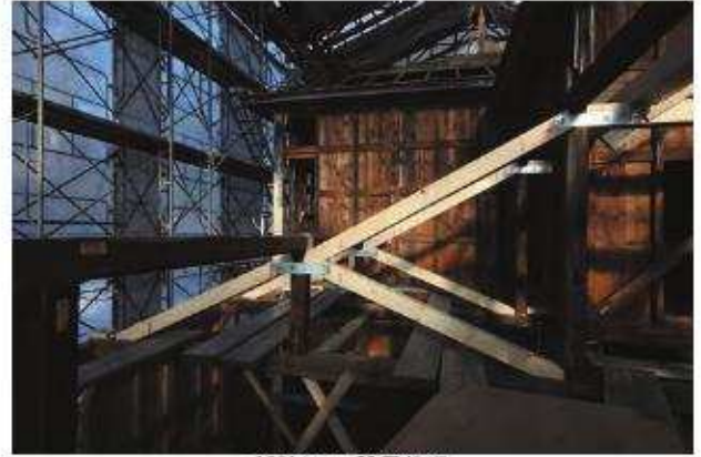
補強トラス設置状況
