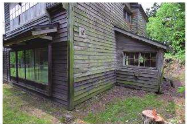
【修理前】「北棟」客室5及び便所外観 北東より
