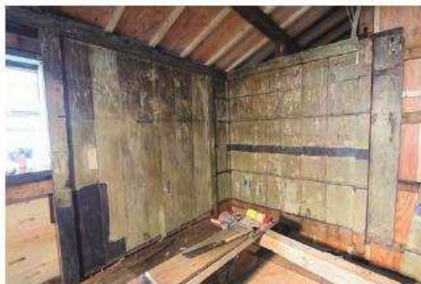
化粧板取付状況 台所 北東よりみる
