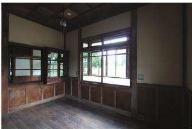
【竣工】事務所 南西よりみる
