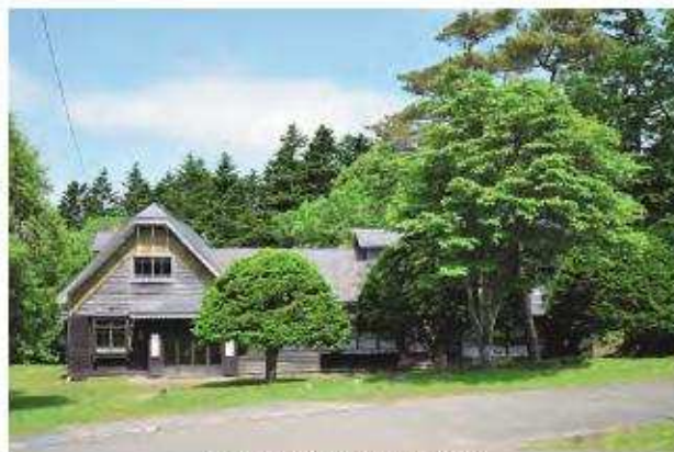
【修理前】外観正面（東面）
