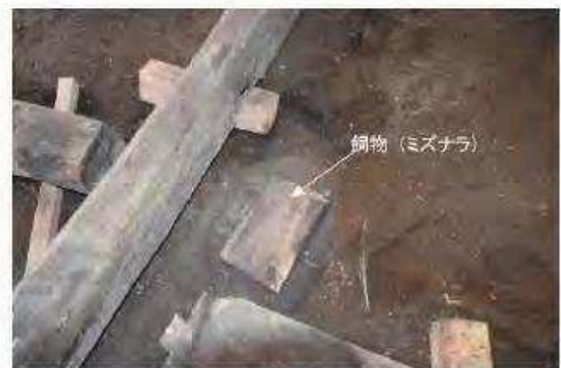
写 3-5-4 「北棟」土台下の飼物
