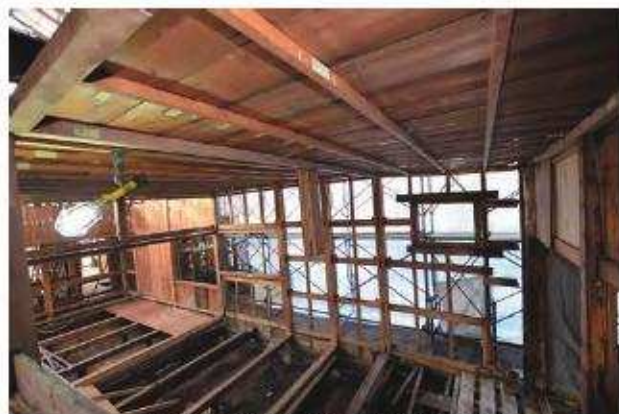
縦板張解体完了 客室2北東よりみる
