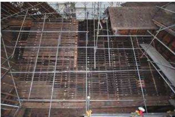
桁葺解体完了 野地板
