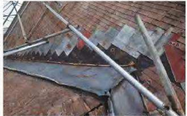
写3-5-10 「南棟」谷に転用されていた旧亜鉛鍍鉄板
