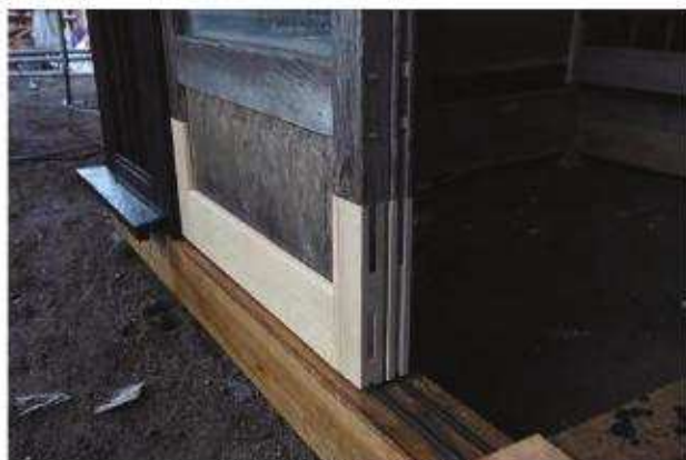
建具組み完了 玄関引戸
