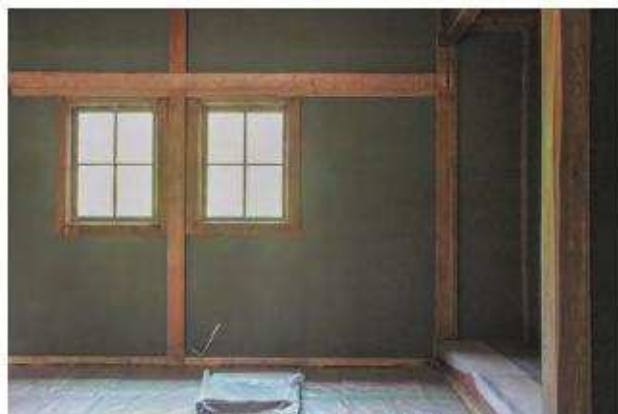
貼付壁施工完了「北棟」客室7
