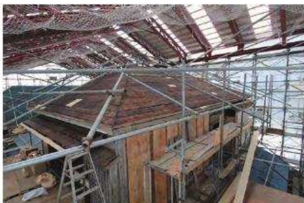
野地板施工完了「北棟」北東よりみる
