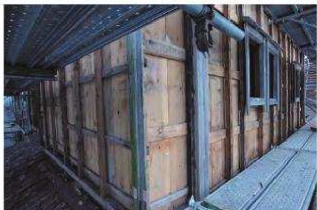
下見板解体完了 二階 北西よりみる
