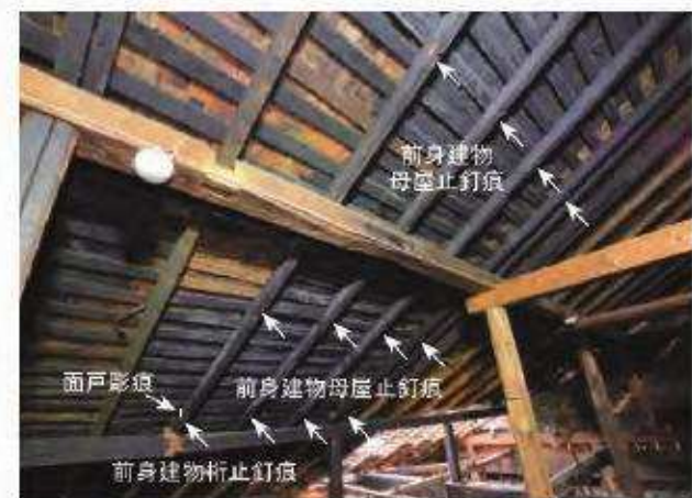
写 3-5-17 「中央棟」前身建物垂木の痕跡
