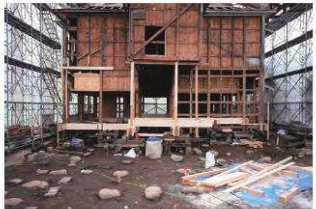
ジャッキアップ状況
