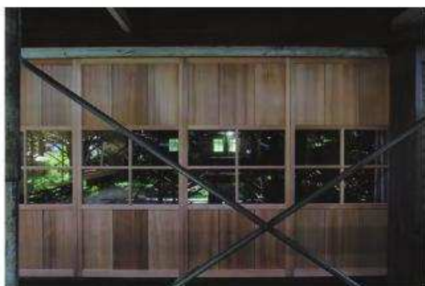
建具施工完了「北棟」客室5 東よりみる
