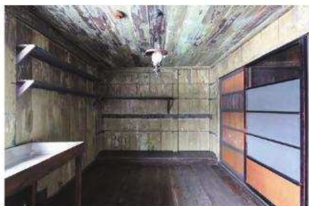
【竣工】台所 東よりみる
