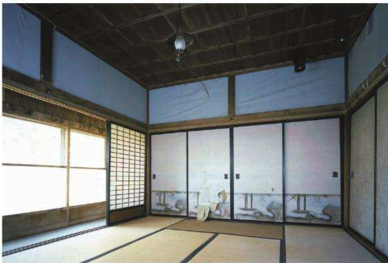
【修理前】 客室 5 北西よりみる
