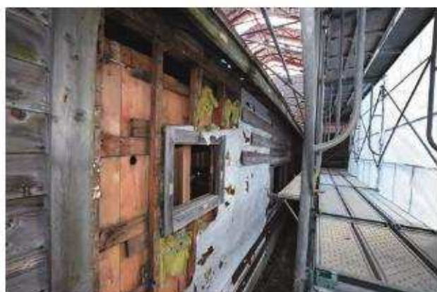
北棟取合い部西側下見板解体完了
