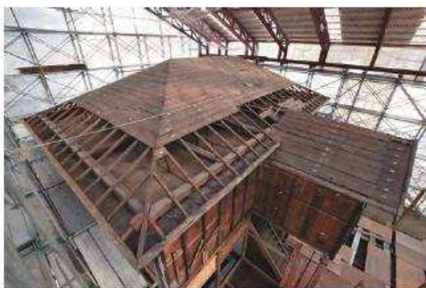
野地板解体完了 (軒先部)
