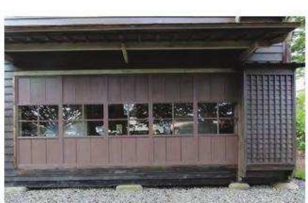
「北棟」復原建具古色塗り完了
