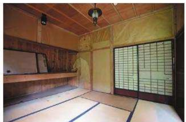
【修理前】客室2南西よりみる
