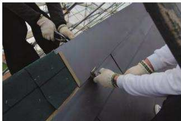
棟包み施工状況
