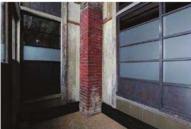
【竣工】裏玄関 南東よりみる
