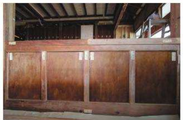
腰板施工完了 事務所 北面
