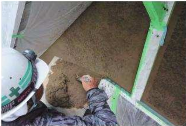
モルタル掃付け作業
