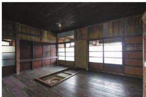
【竣工】居間 北西よりみる
