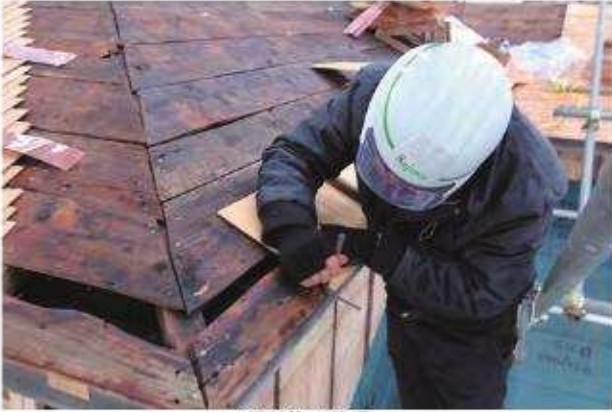
軒付施工状況
