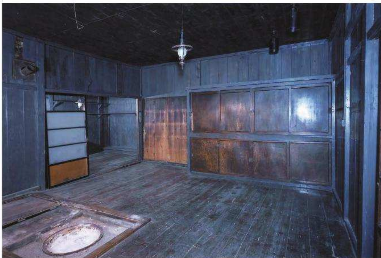
【修理前】居間北東より台所を見通す
