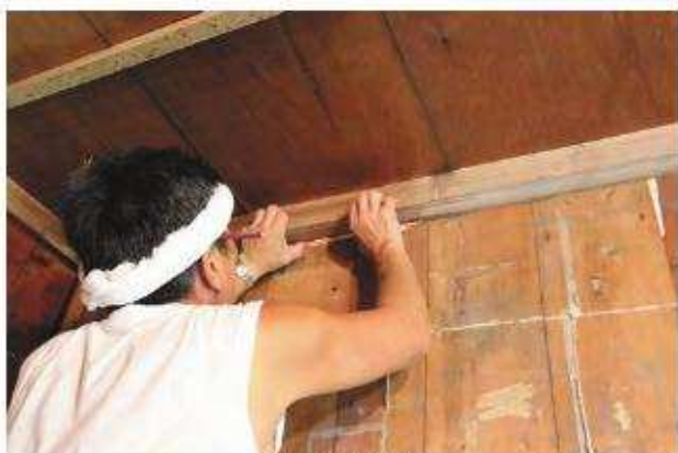
下地調整作業
