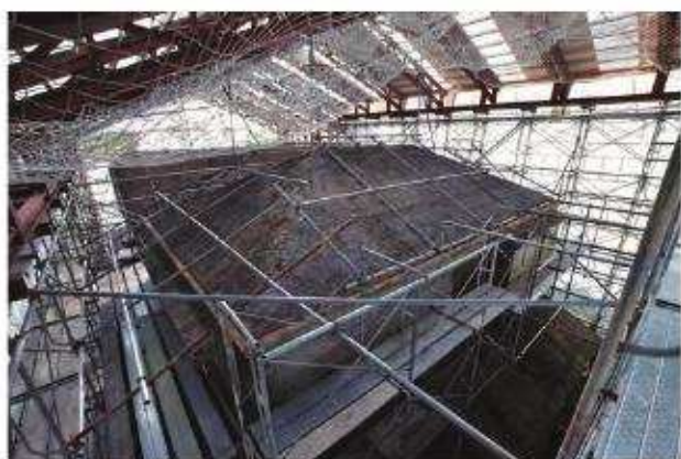
素屋根内部 北東よりみる
