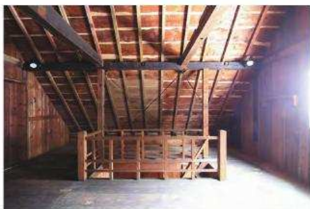
【竣工】小屋裏物置 北よりみる
