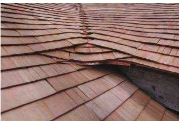
谷部施工完了
