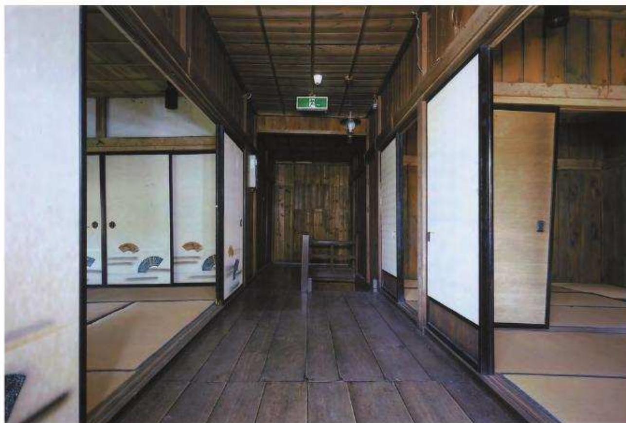
【修理前】二階廊下 北よりみる
