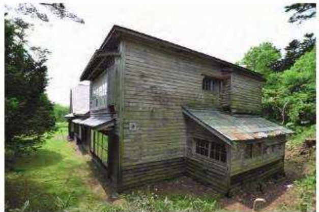
【修理前】外観 北東より
