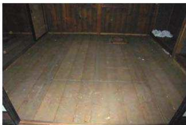
荒床 客室7 東よりみる
