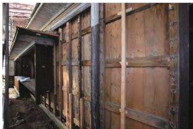
西面下見板解体完了 南西よりみる
