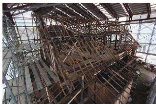
小屋組立完了「南棟」南西よりみる
