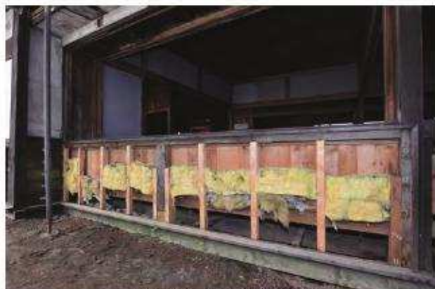
茶の間窓台 下見板解体完了
