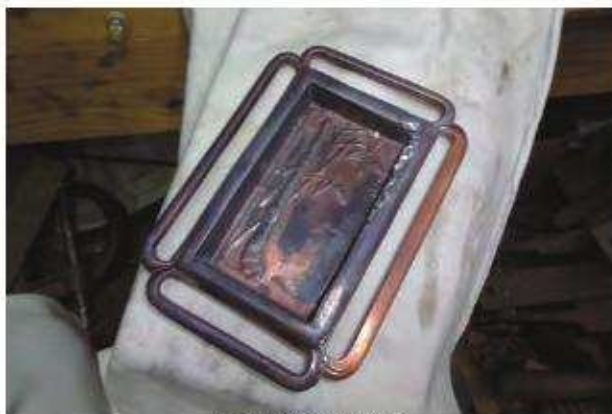
欠損部半田接合完了
