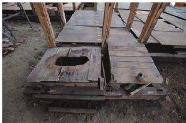
後設化粧床板撤去状況 便所 西よりみる
