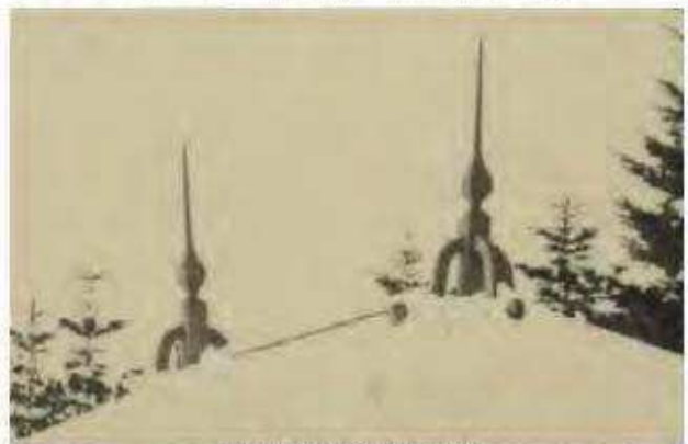
昭和15年頃の棟飾り詳細 鮮明に写っており角柱であることがわかる。雪があり脚部が見えない。
