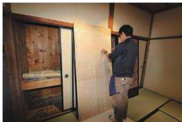
袋貼作業状況
