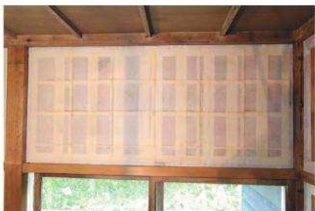
袋貼施工完了
