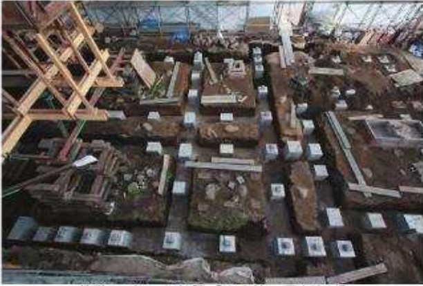
基礎コンクリート打設「中央棟」西よりみる
