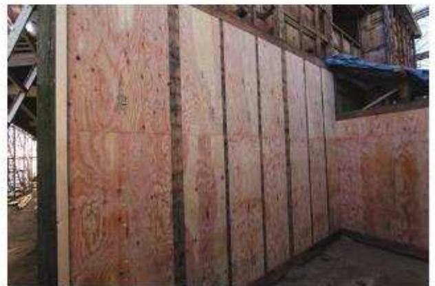
耐力壁施工状況「北棟」北面
