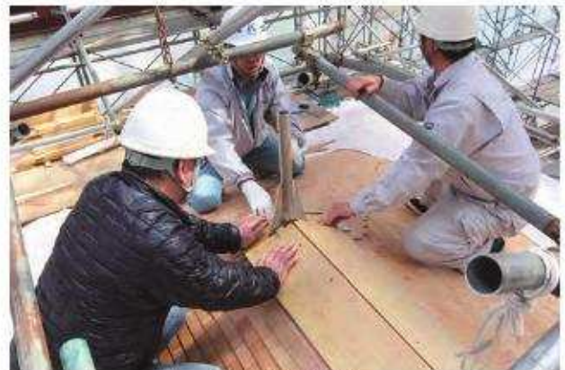
補強金物据付状況
