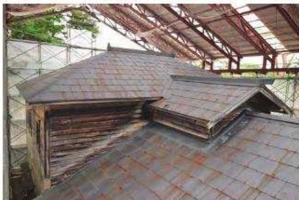
解体前状況 南西よりみる
