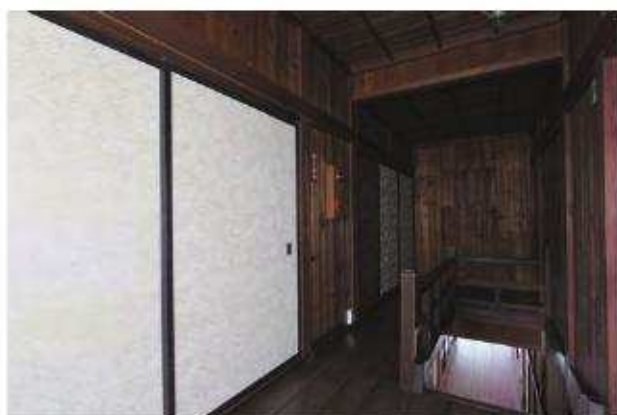
【竣工】「北棟」二階廊下 北西よりみる
