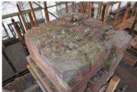
煉瓦煙突内に充填されたコンクリート
