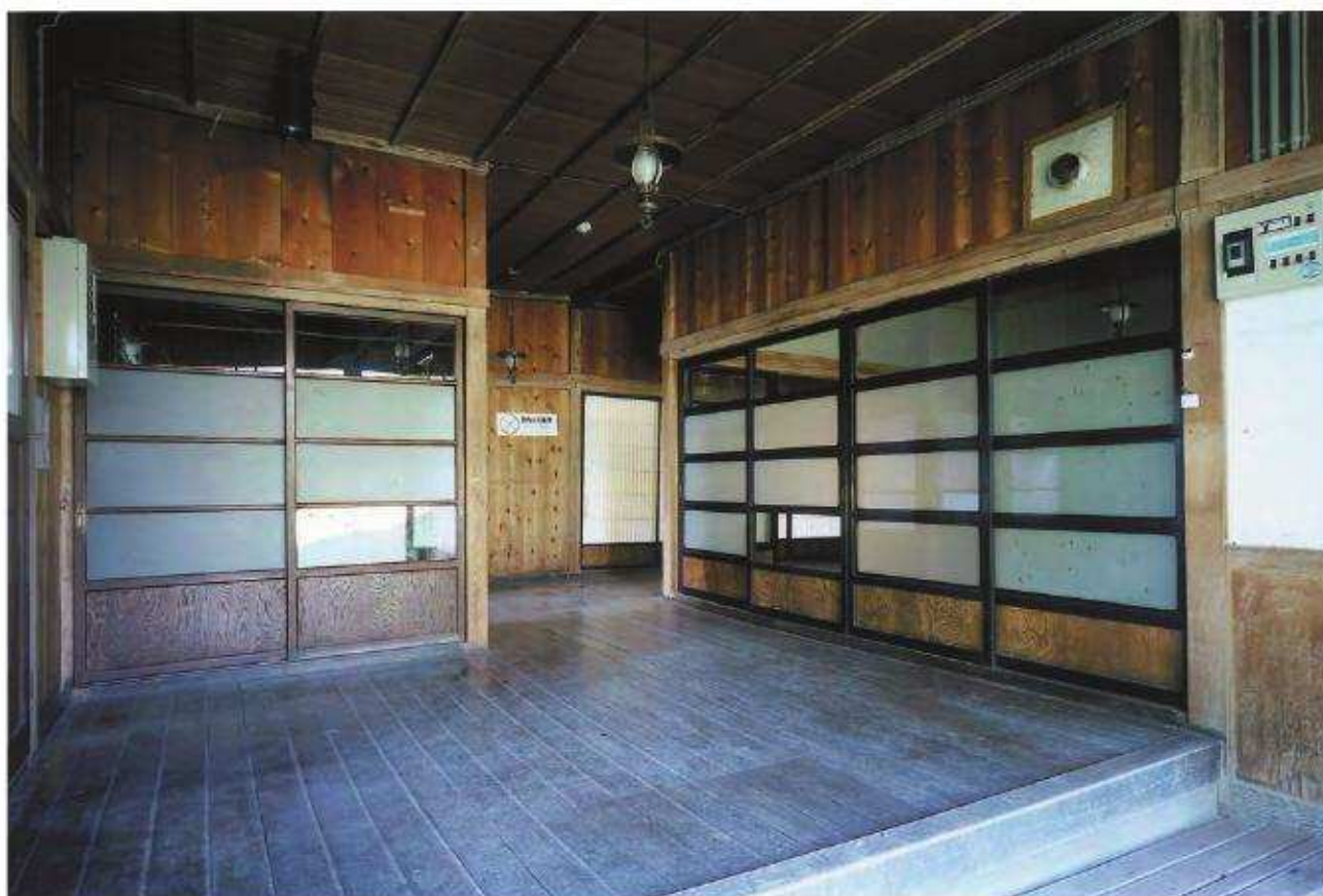
【修理前】玄関 南東よりみる
