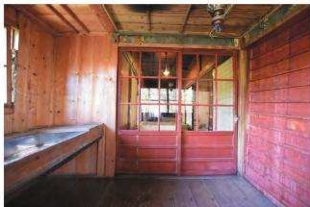
【修理前】「北棟」洗面所 北よりみる
