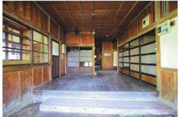
【修理前】玄関 正面
