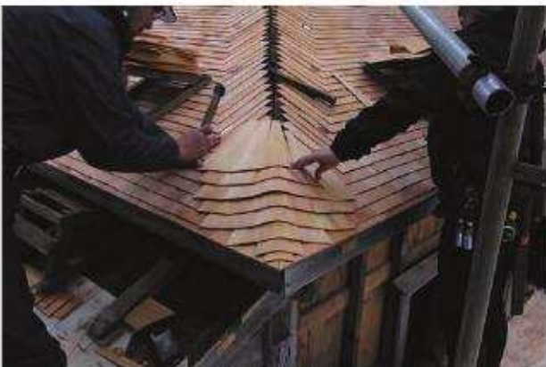
隅棟施工状況
