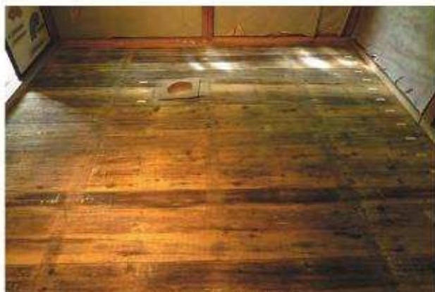
荒床 客室4 東よりみる
