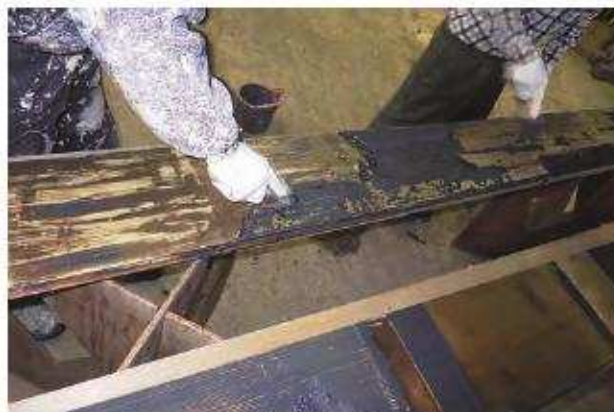
既存塗膜剥離作業
