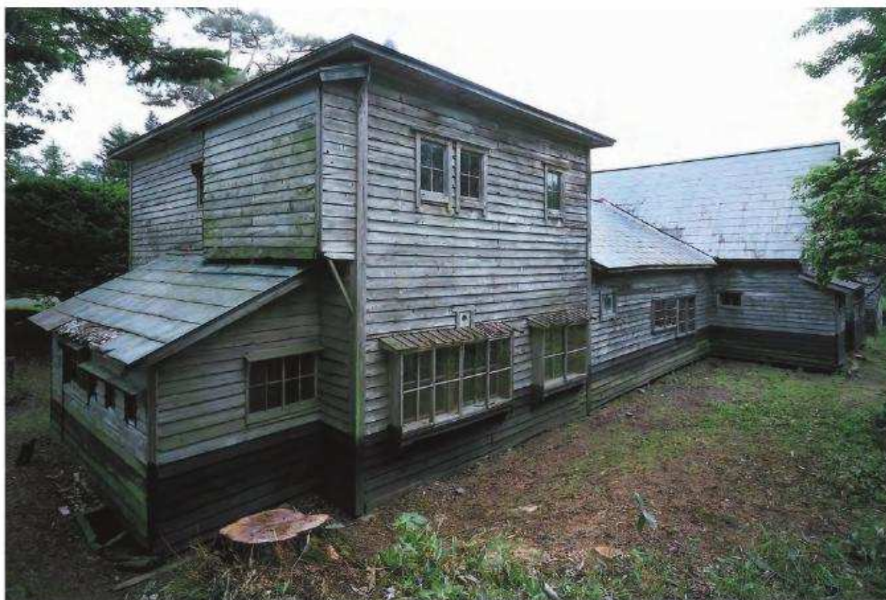
【修理前】外観 北西よりみる
