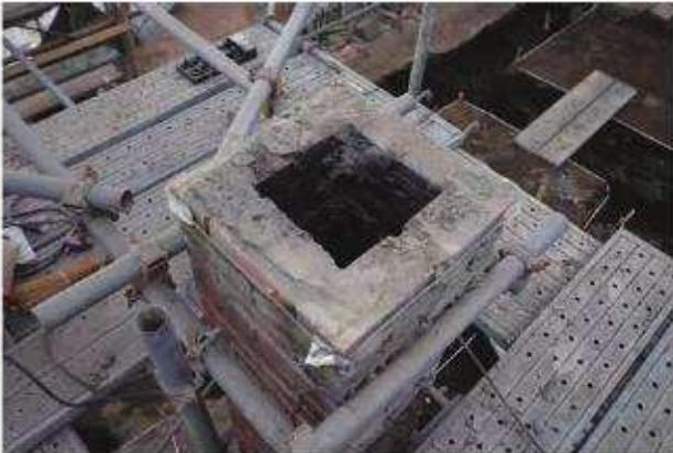
煙突切断面
