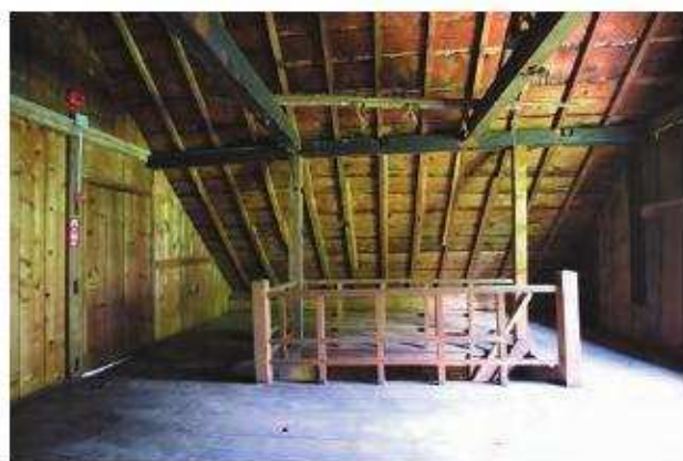
【修理前】小屋裏物置 北よりみる
