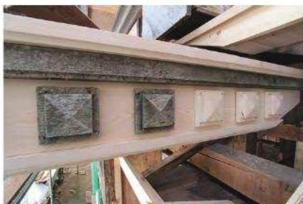
装飾補修状況 玄関鼻隠し
