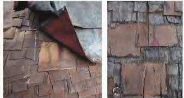
写3-5-11 左：片面が赤く塗られる 右：葺葺に付着した赤い塗料
