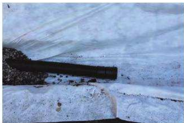
雨落溝有孔管、砂利敷設状況
