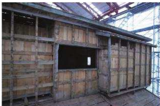
下見板解体完了 二階北面
