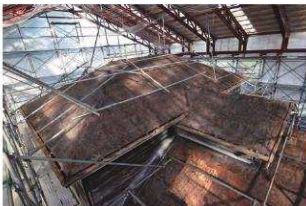
鋼板葺解体完了 桁葺
