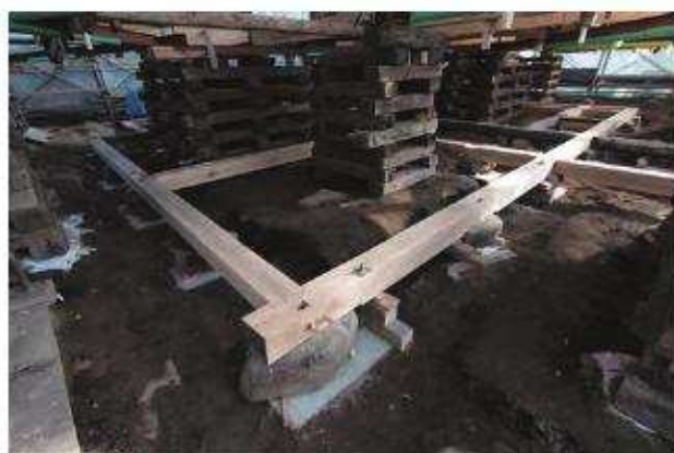
土台組立完了「北棟」南西よりみる
