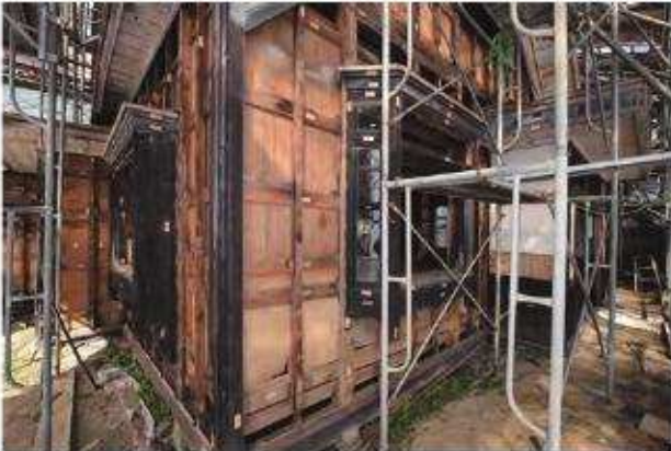
下見板解体完了 南東よりみる
