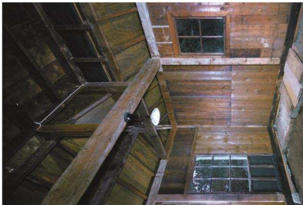
【竣工】物置 北東よりみる
