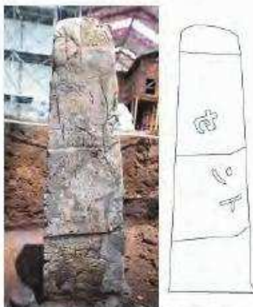
写 3-5-3 コンクリート独立基礎地業 (L=70 cm) 型枠の剥離に用いたセメント袋の文字が転写されている。
