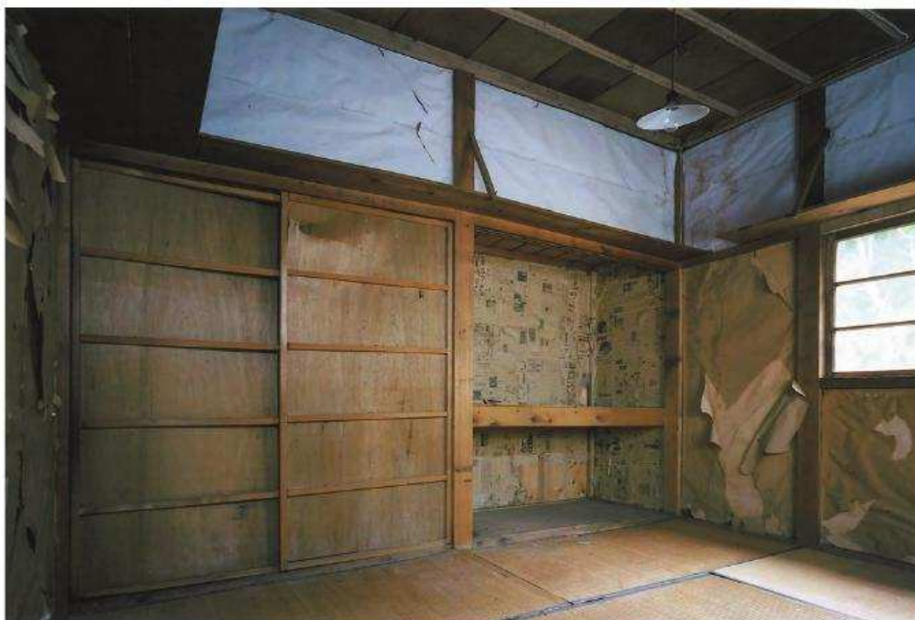
【修理前】 使用人室 北東よりみる
