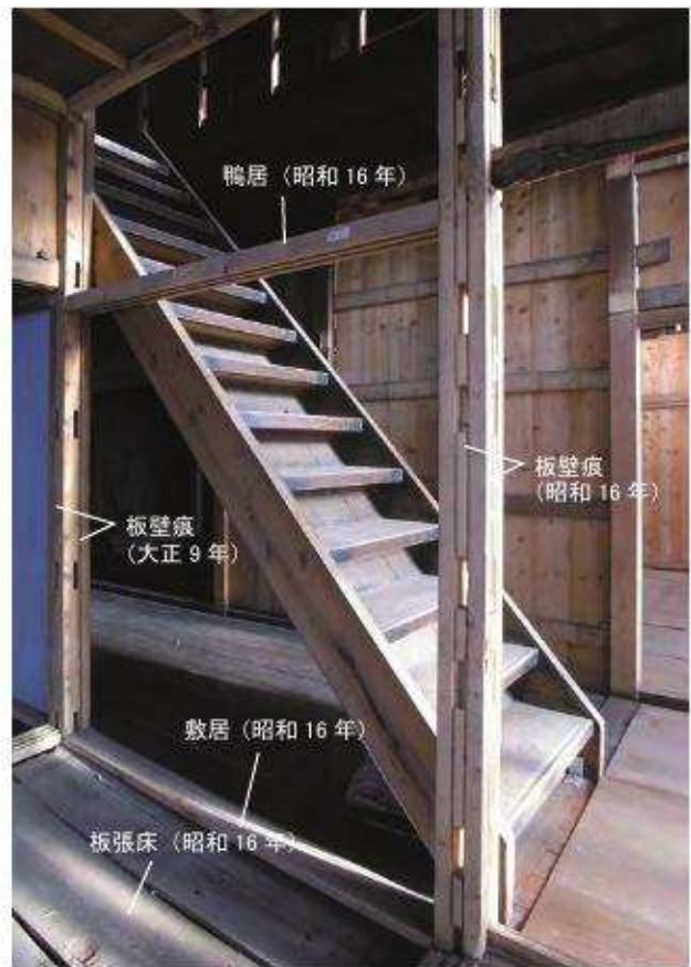
客室2・3境押入東面の壁板撤去状況 壁板を撤去したところ旧開口部の敷鴨居が現れた。床板は天端を仕上げてあり板張であったことがわかる。「北棟」側の柱には「北棟」創建時の板壁であった痕跡(貫、板溝、下見板釘痕)がある。
