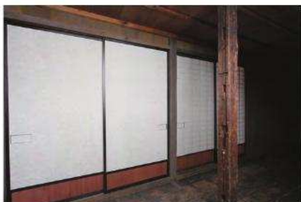
【竣工】小屋裏廊下 南西よりみる
