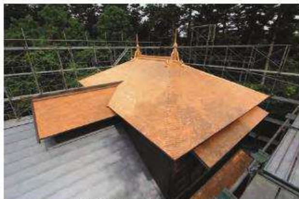
葺葺施工完了「北棟」南東よりみる
