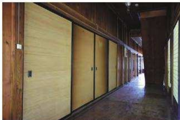
【修理前】「北棟」廊下 北西よりみる
