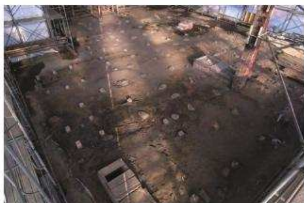
土台解体完了 礎石
