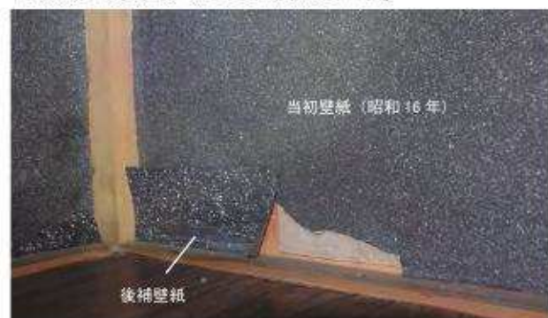
写3-5-40 仏間トコ壁紙の補修痕 仏間トコ壁紙の補修には「北棟」の後補材と同じ紙が用いられる。
