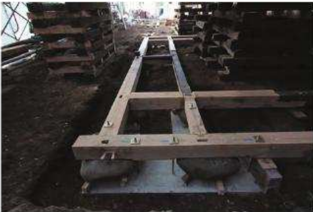
アンカーボルトと土台の緊結状況
