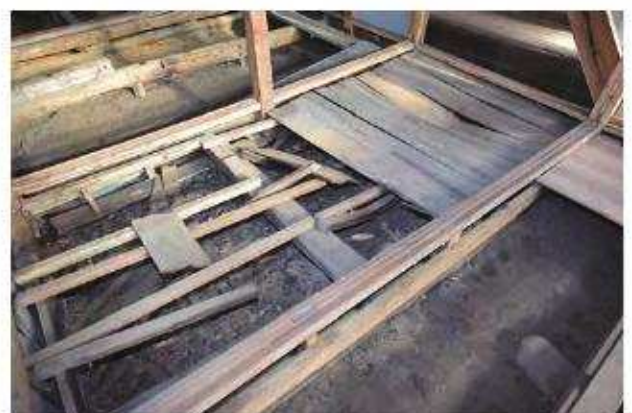
後設床板撤去状況 客室2より客室2押入、客室3押入をみる
