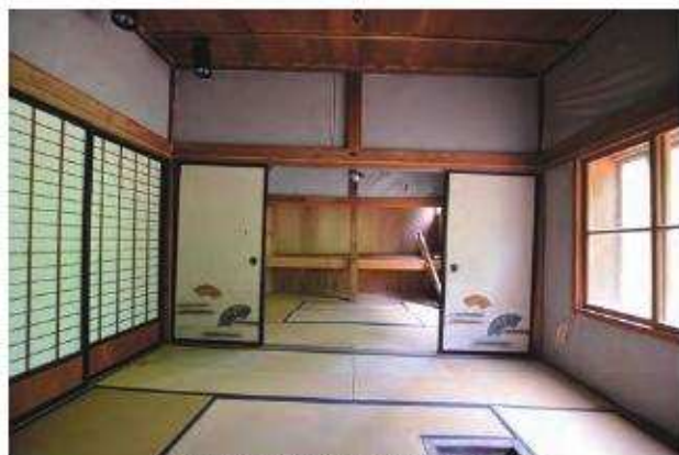
【修理前】 客室4より客室3を見通す
