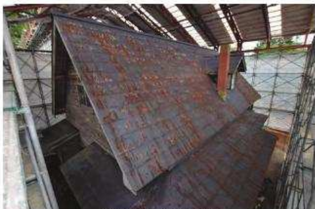
解体前状況 北東よりみる
