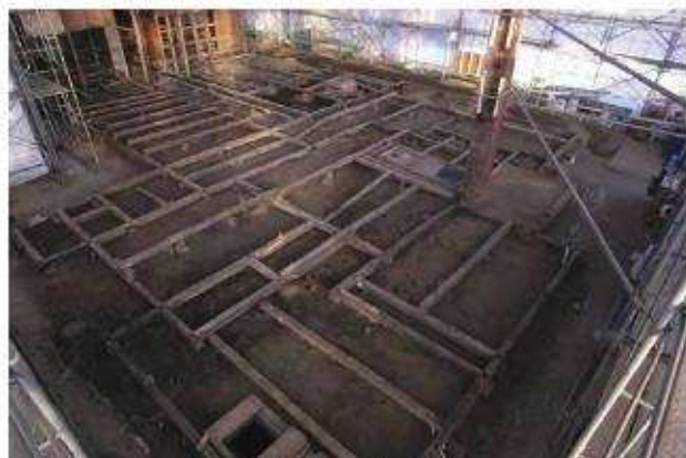
軸組解体完了 土台
