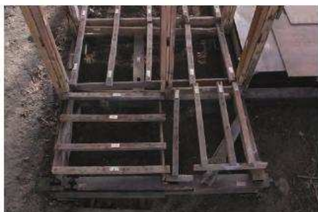
床板撤去状況 床組 便所 西よりみる
