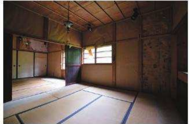
【修理前】客室2北東より客室1を見通す
