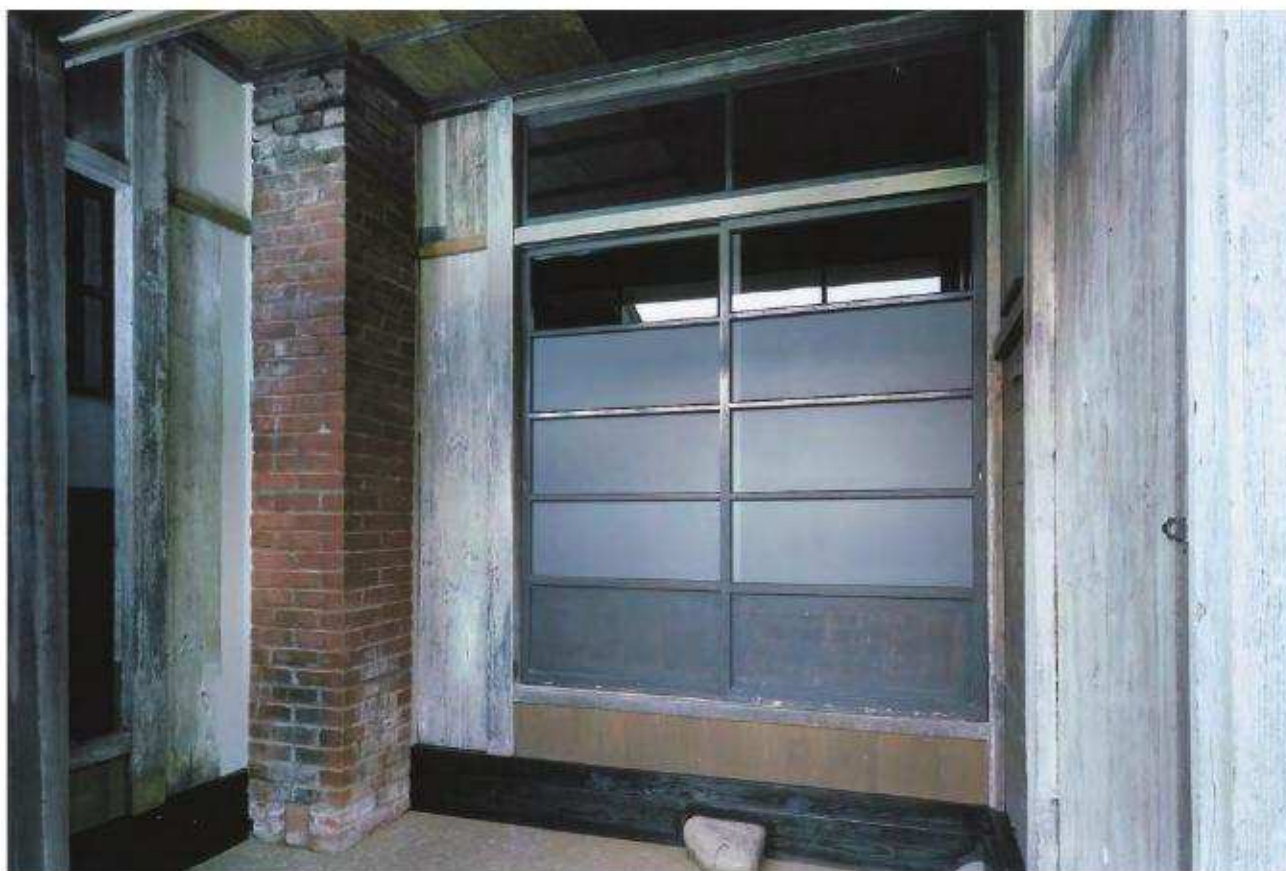
【竣工】裏玄関 南東よりみる
