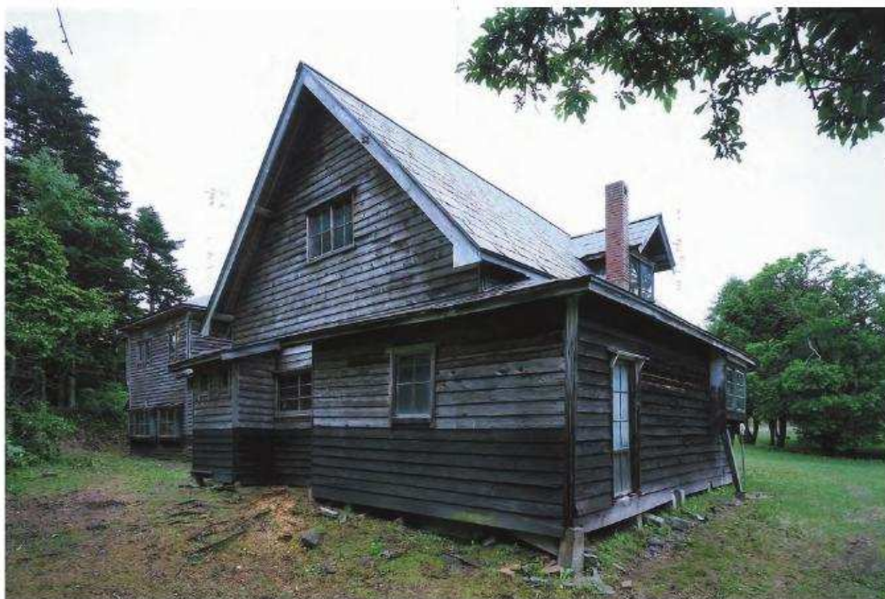
【修理前】外観 南西よりみる
