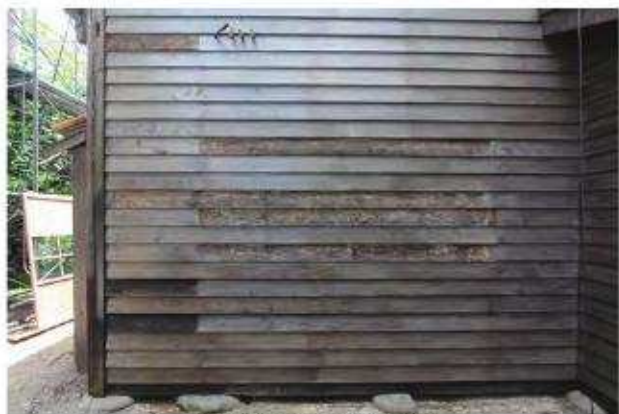
古色塗り完了「北棟」北面
