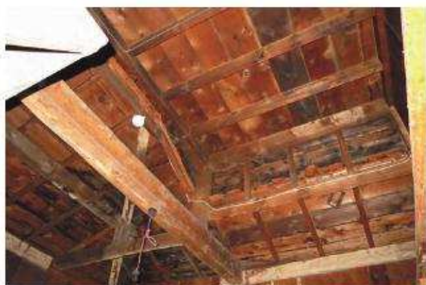
【修理前】 物置 小屋現わし天井
