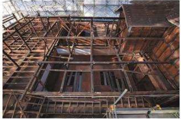
垂木解体完了 小屋組
