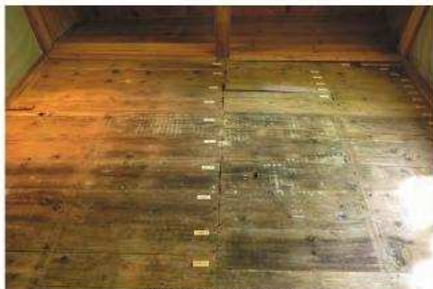
荒床 客室3 北よりみる
