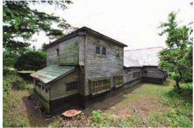
【修理前】外観 北西より
