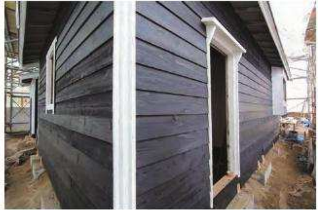
外壁塗装完了「南棟」南西よりみる
