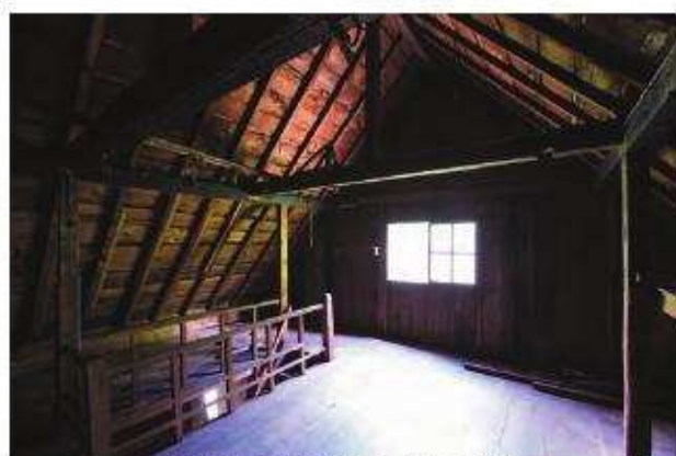
【修理前】小屋裏物置 北東よりみる
