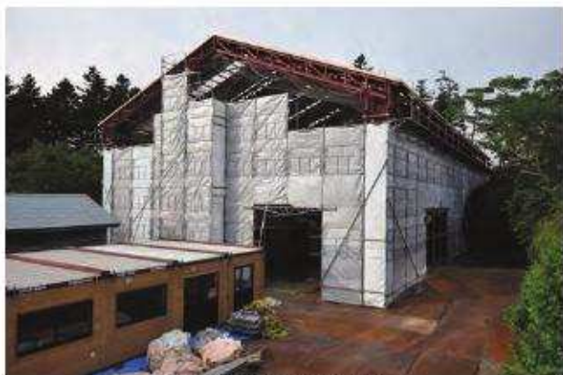
素屋根外観 南東よりみる
