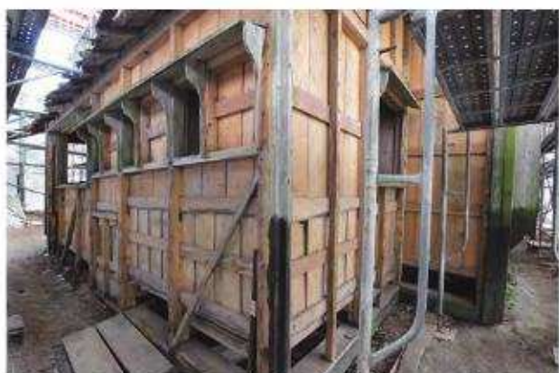
下見板解体完了 便所 北西より見る
