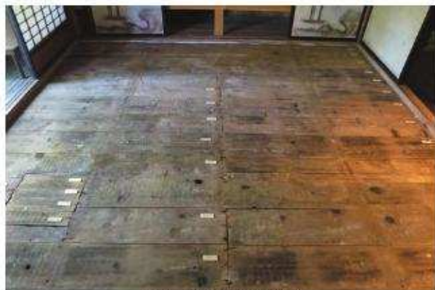
荒床 客室5 北よりみる
