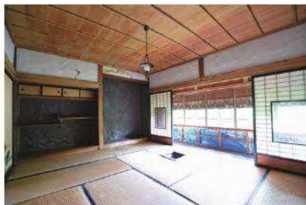
【修理前】客室8 南西よりみる
