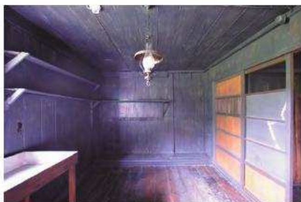
【修理前】台所 東よりみる
