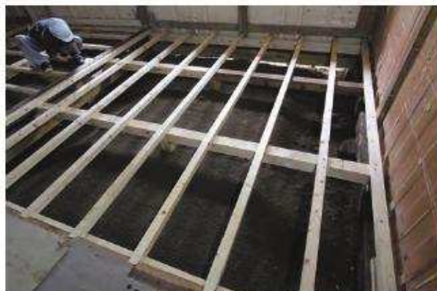
床組 組立状況 客室4
