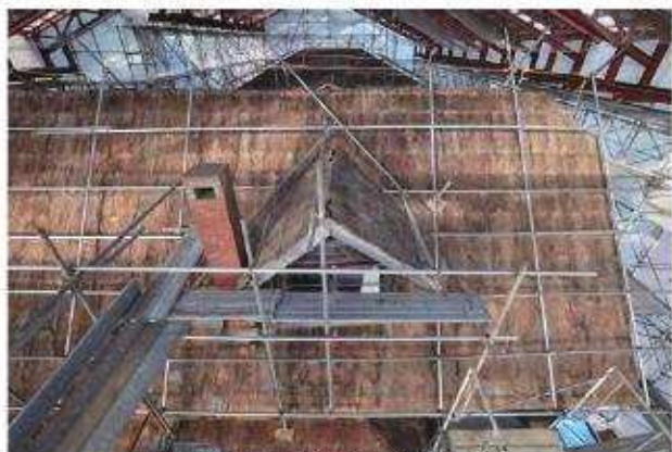
「南棟」屋根面足場 南よりみる
