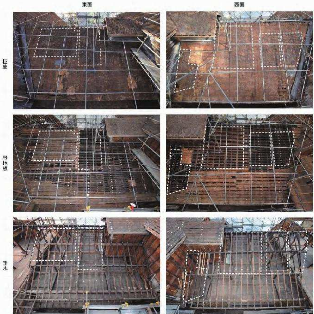
写 3-5-18 「中央棟」に再用された前身建物の屋根部材
