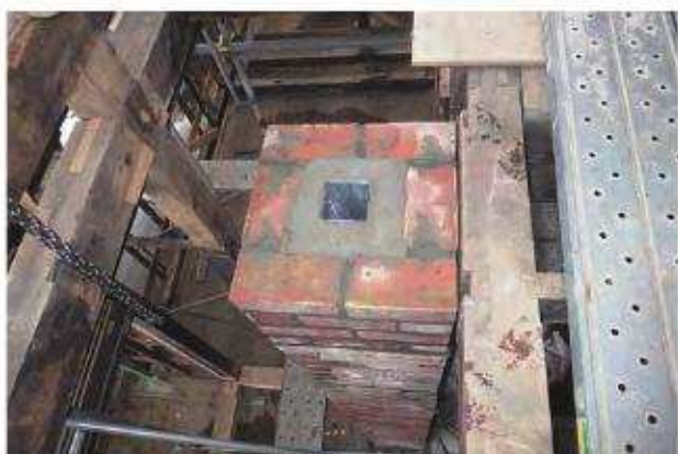
煙突組立状況
