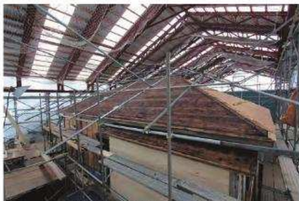
野地板施工完了「北棟」北西よりみる
