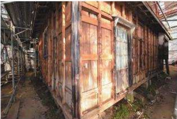
下見板解体完了 南西よりみる
