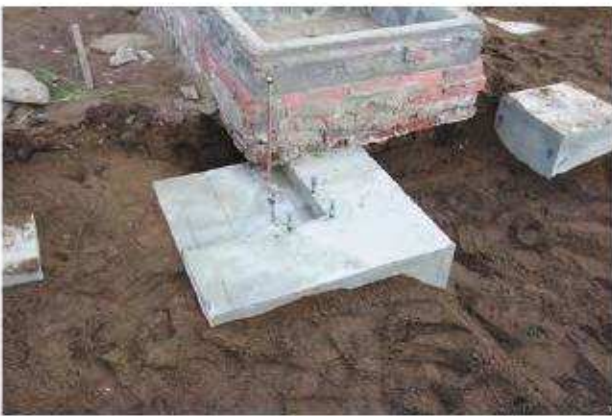
煙突部基礎コンクリート
