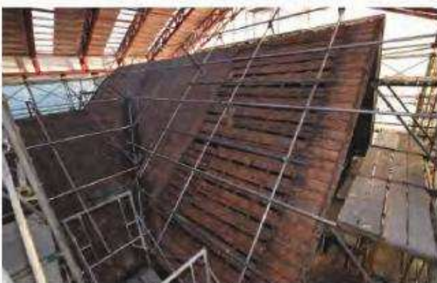
写 3-5-15 「南棟」野地板 平には丸太挽の板を並べ、鯉羽には整形した板を突付で並べる。
