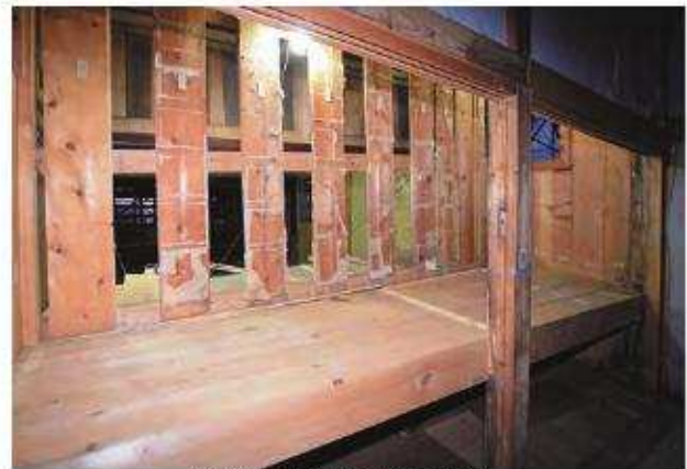
客室2・3境に設けられた押入 間仕切壁は簡易的で窓にぶつかる。
