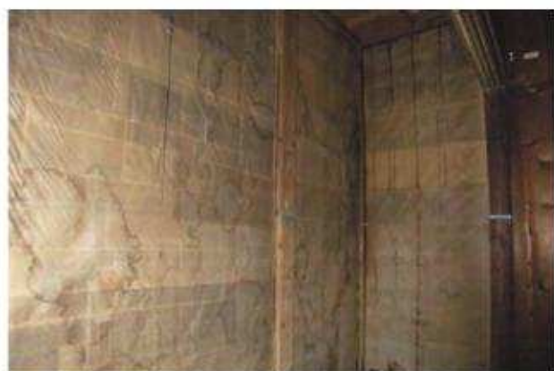
修理前袋貼仕上 二階廊下押入
