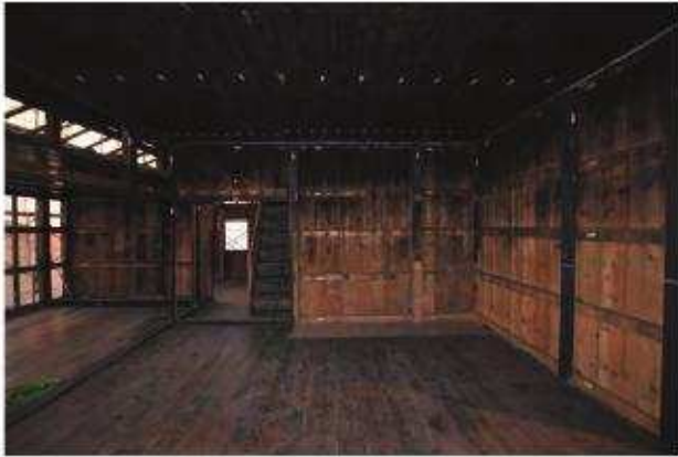
化粧板解体完了 居間 東よりみる
