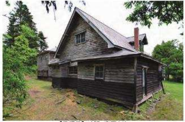
【修理前】外観 南西より
