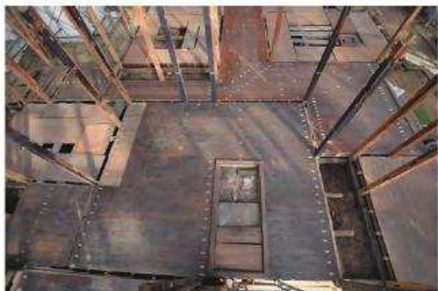
床板 居間 南よりみる
