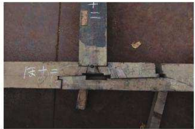
写3-5-1 「南棟」物置転用土台同士の継手位置のずれ
