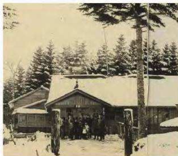
図 3-3-6 Ⅲ期とⅣ期の山藤のマツと玄関位置の比較 ほぼ正面から撮られた2枚の写真であるが、Ⅳ期の改造時に玄関位置が北へ移動したことがわかる。
