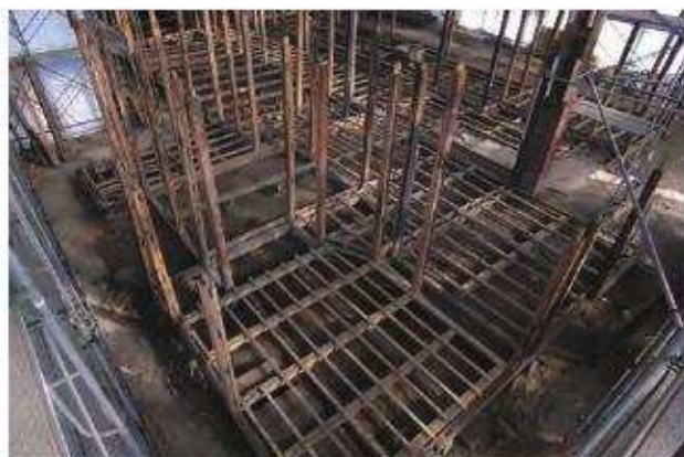
二階床組解体完了 一階軸部
