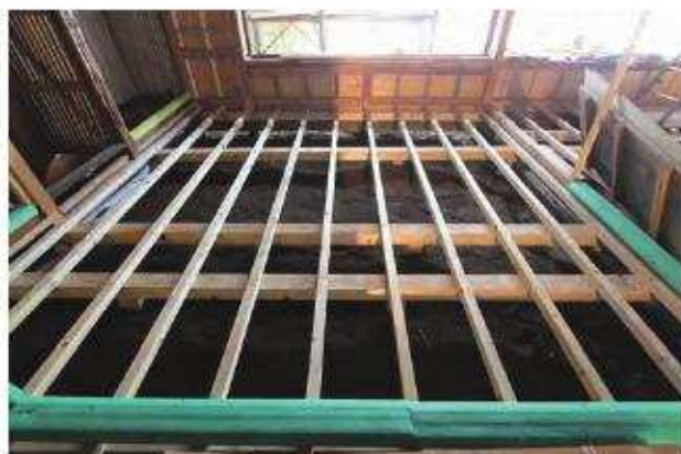
床組組立完了「南棟」仏間 西よりみる
