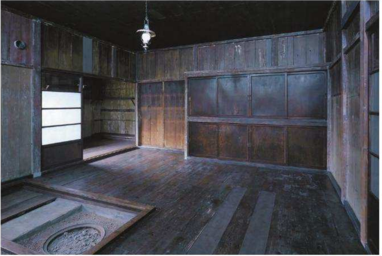
竣工 居間北東より台所を見通す
