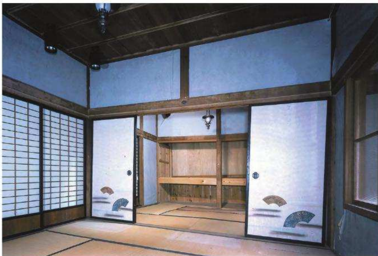
【修理前】 客室 4 北西より客室 3 を見通す
