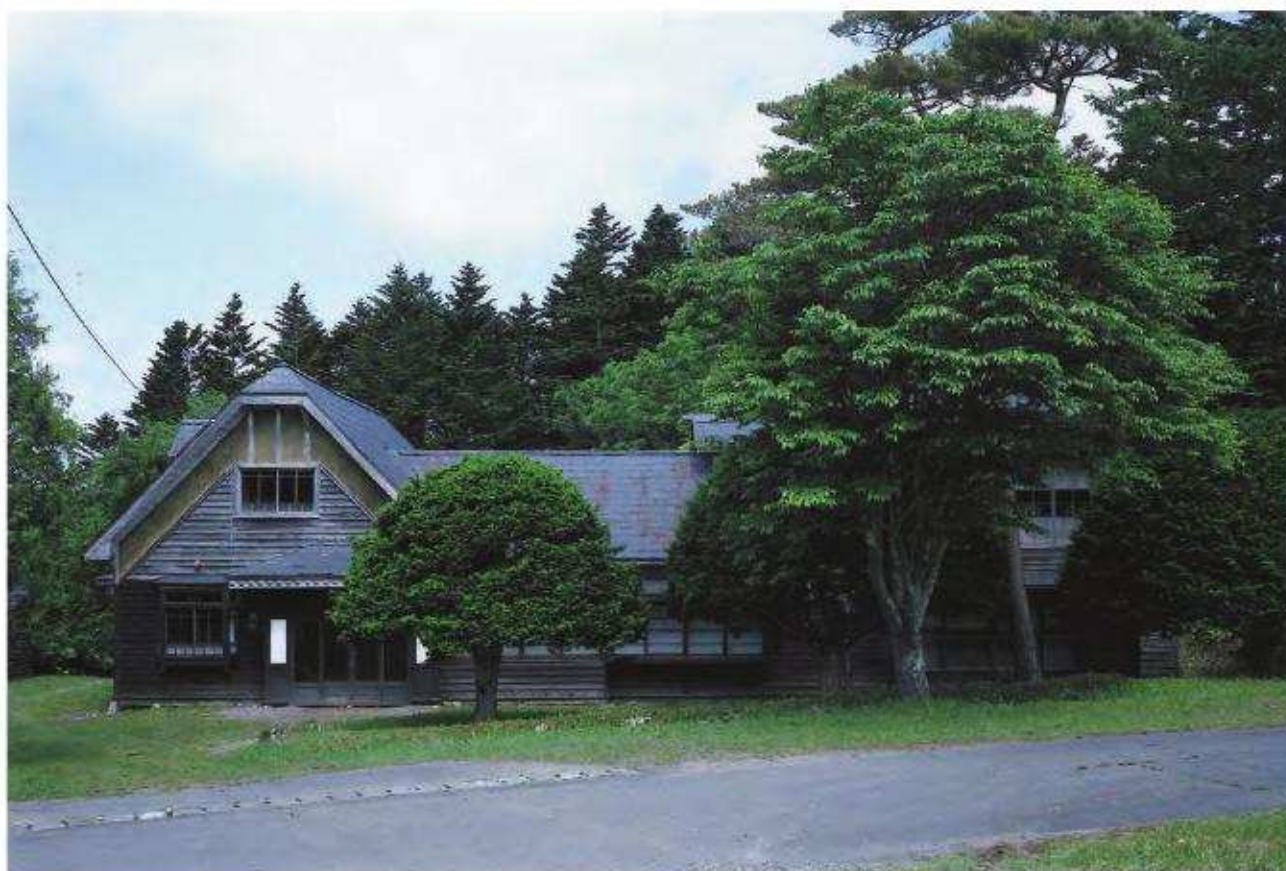
【修理前】外観正面（東面）
