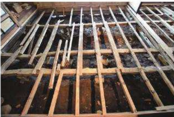
荒床解体完了 床組 仏間 西よりみる
