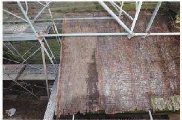
遺存していた「北棟」便所増築部の桁葺
