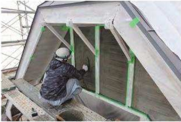
下塗り施工状況
