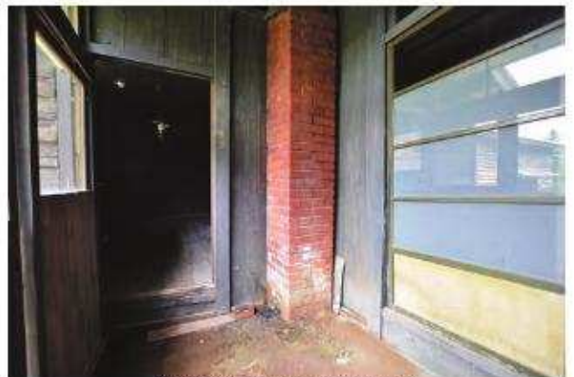
【修理前】裏玄関 南東よりみる
