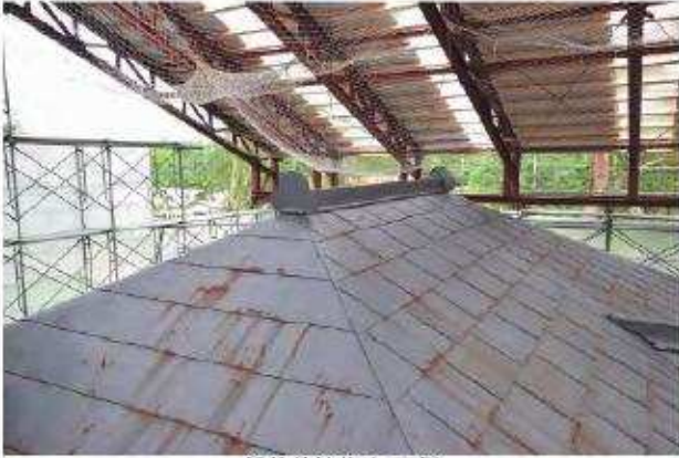
解体前棟飾り 西側
