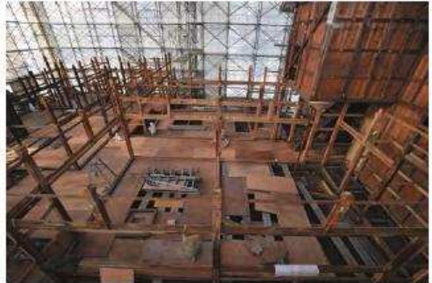
小屋組解体完了 軸部
