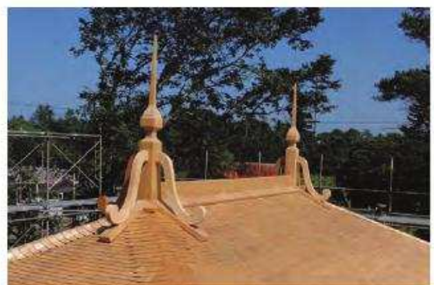
棟飾り施工完了
