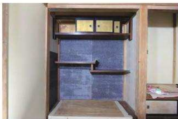
貼付壁施工完了「南棟」仏間床脇
