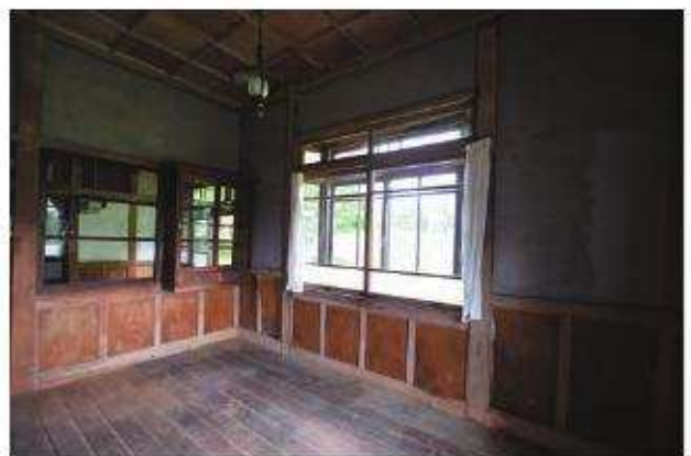
【修理前】事務所 南西よりみる
