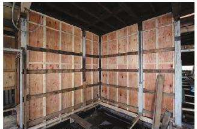
耐力壁施工状況 居間 南東よりみる
