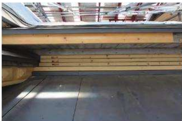
木摺施工完了「中央棟」東面小壁 東よりみる
