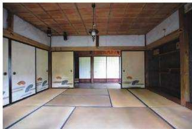
【修理前】客室8 東より廊下を見通す
