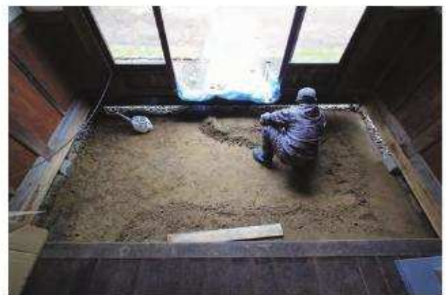
三和土施工状況 玄関土間
