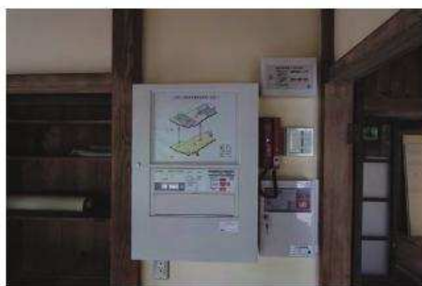
分電盤等取付完了
