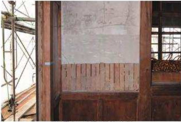
壁面層出し 玄関内脇壁 南側
