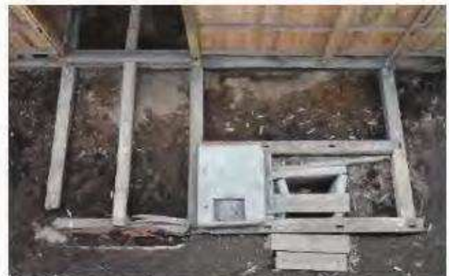
「北棟」便所 土台とコンクリート便槽
