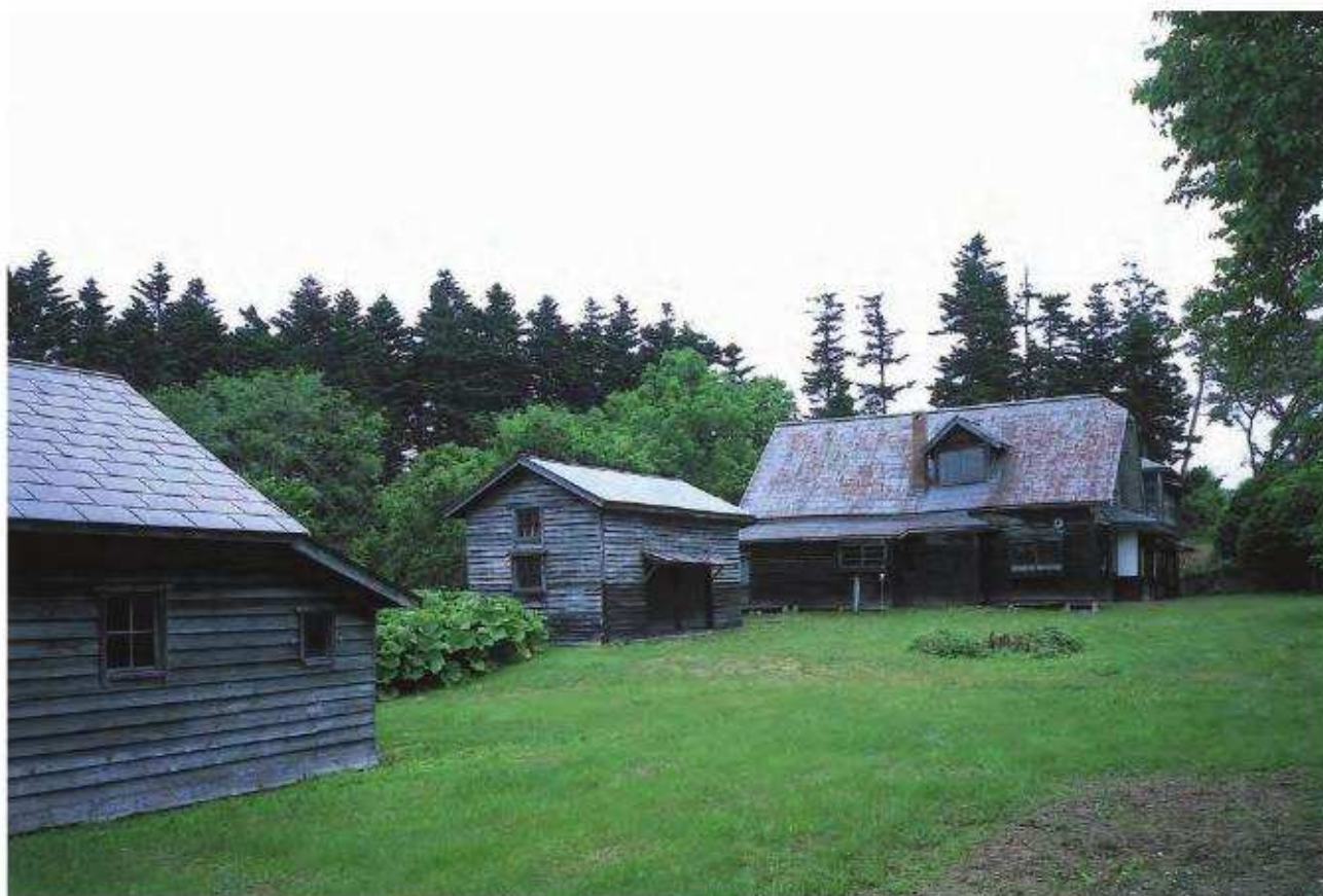
【修理前】外観 南東よりみる
