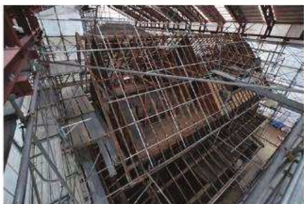
野地板解体完了 垂木
