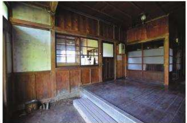
【修理前】玄関 北東よりみる
