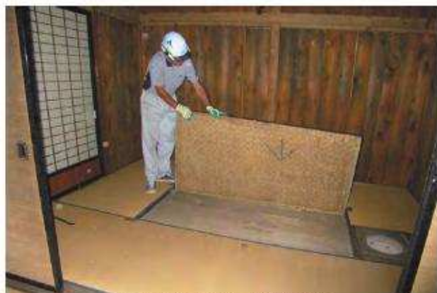
畳撤去状況 客室6 北西よりみる
