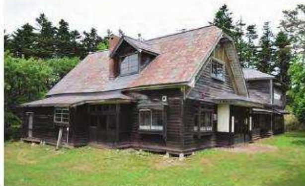
【修理前】外観 南東より
