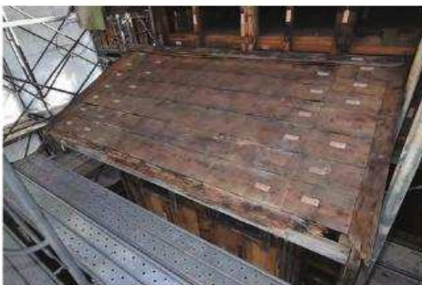
野地板 西側下屋 南西よりみる
