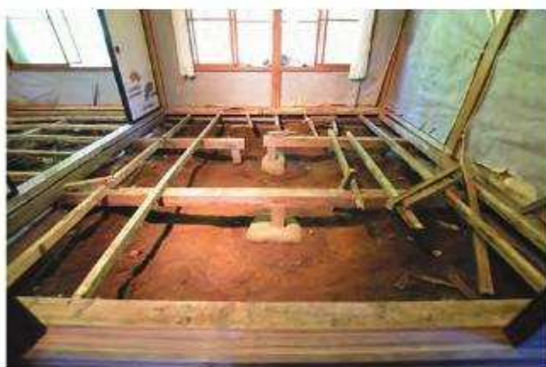
荒床解体完了 床組 客室4 東よりみる
