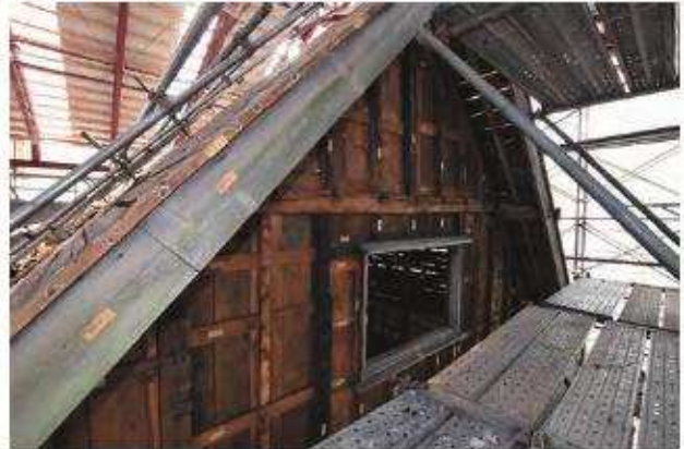
下見板解体完了 西面
