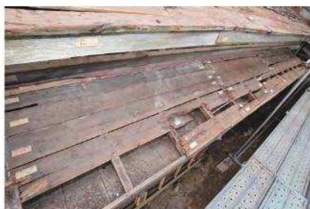
野地板 東側庇 南東よりみる
