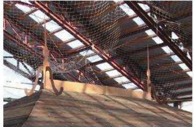
現寸型板（モックアップ）据付検討状況
