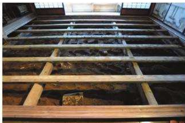
荒床解体完了 床組 客室5 西よりみる
