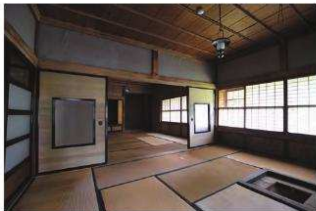
【修理前】茶の間北西より仏間を見通す
