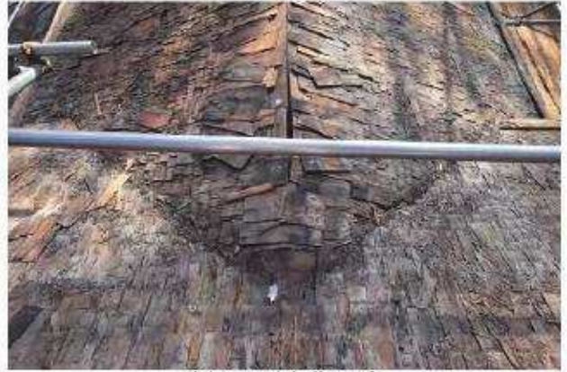
遺存していた桁葺の谷部
