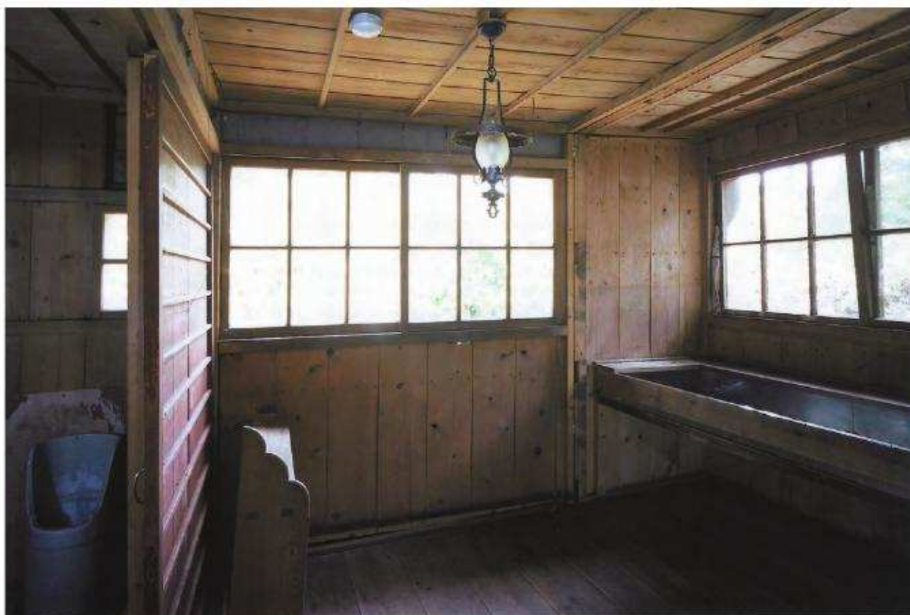
【修理前】洗面所 南西よりみる
