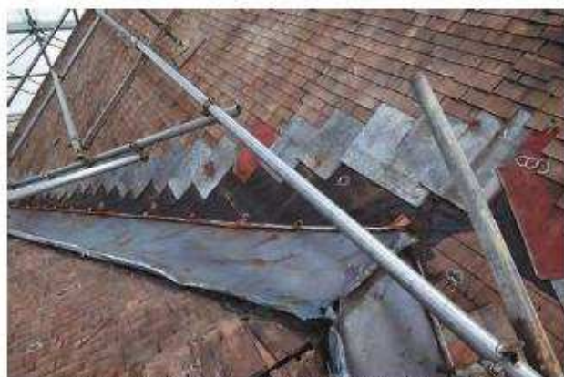
「南棟」との谷に差し込まれた旧亜鉛鍍鉄板（東側）
