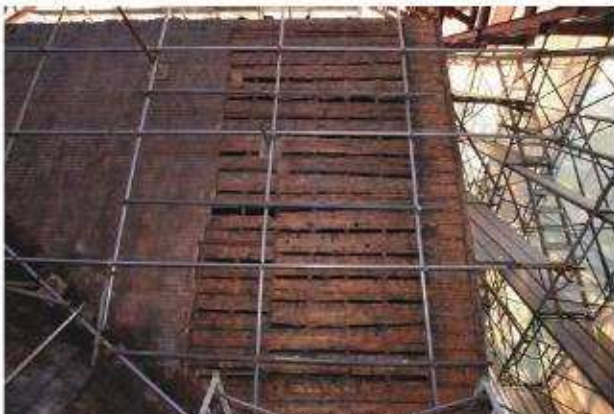
桁葎解体 西側北面野地板
