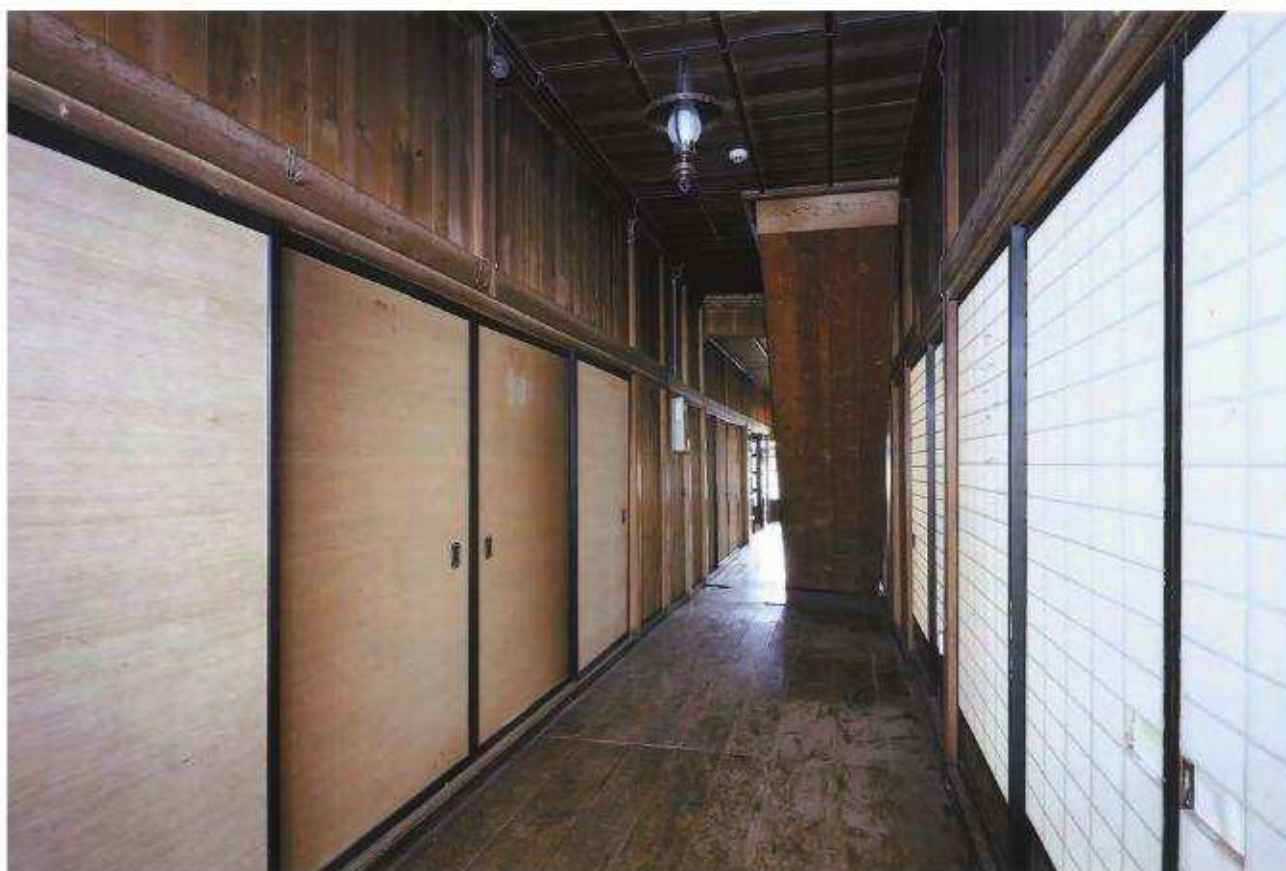
【修理前】一階廊下 北よりみる
