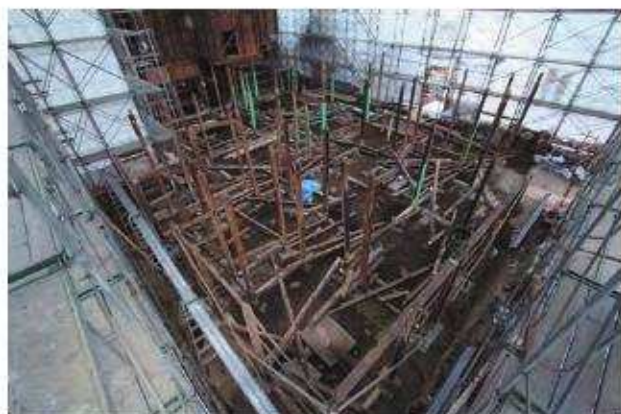
一階柱組立完了 南西よりみる
