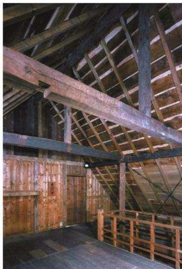
【竣工】小屋裏物置 北西よりみる
