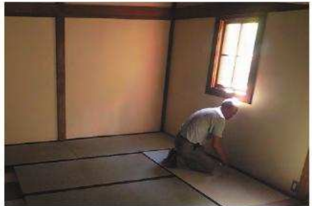
畳敷込み状況
