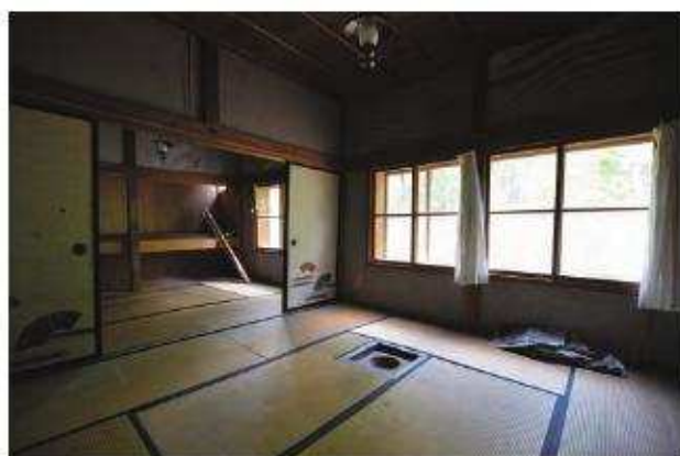
【修理前】 客室4 北東より客室3を見通す
