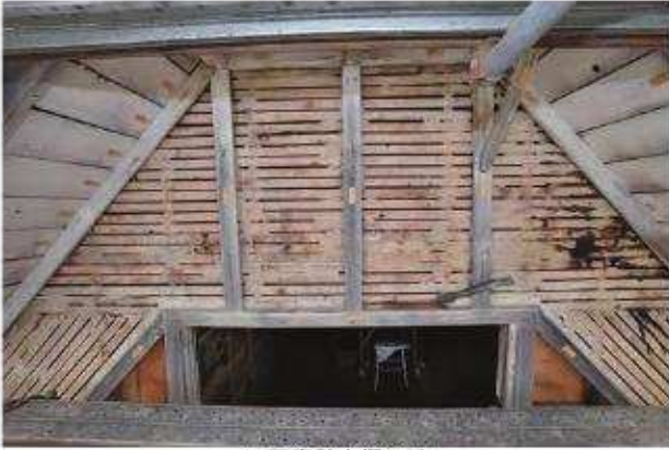
正面妻壁木摺下地
