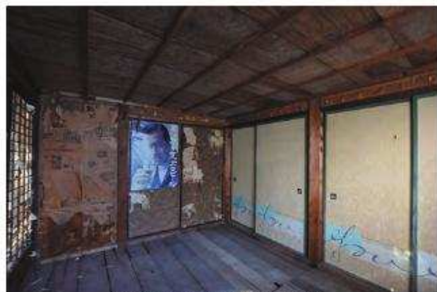
【修理前】和室2 南東よりみる
