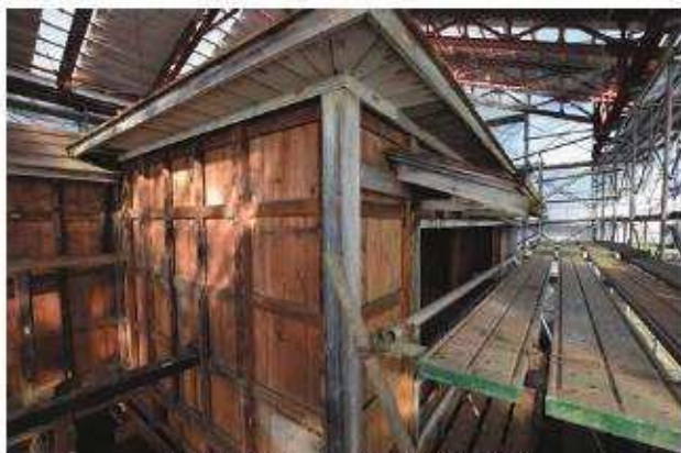
下見板解体完了 二階 南東よりみる
