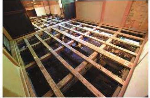
荒床解体完了 床組 客室2 北東よりみる
