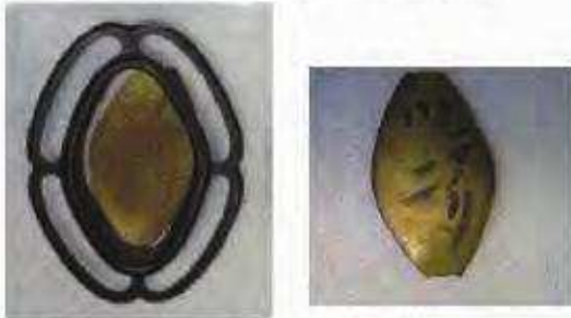
写 3-5-62 客室7天袋引手 (左:表 右:底板裏)
