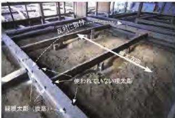
写3-5-5 客室5の足固め
