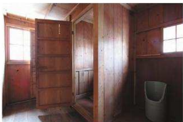
【竣工】「北棟」便所 南東よりみる
