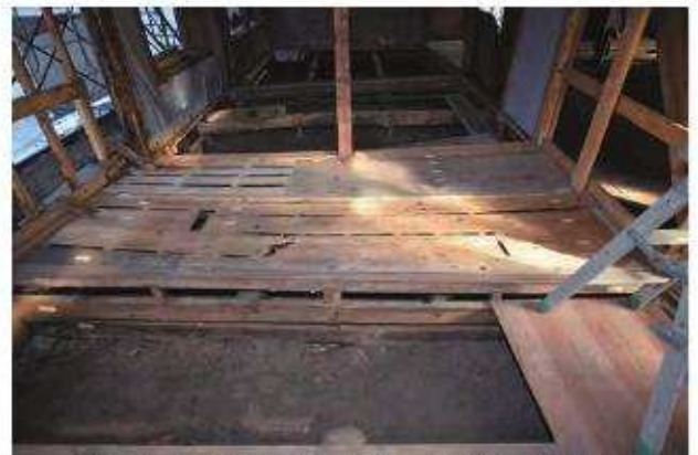
後設床板 客室2より客室2押入、客室3押入をみる
