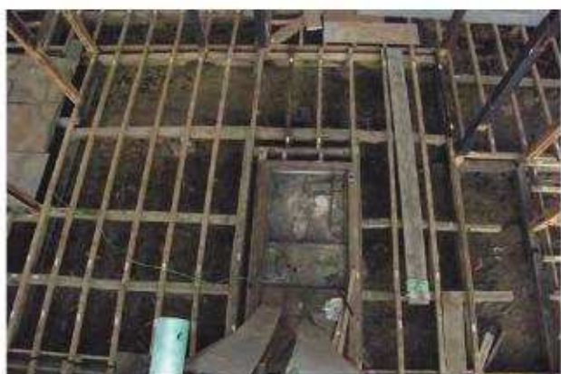
床板解体完了 床組 居間 南よりみる
