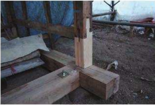
柱根継ぎ状況
