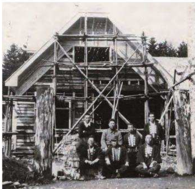
史 14 「南棟」改築工事中（昭和 16 年）
