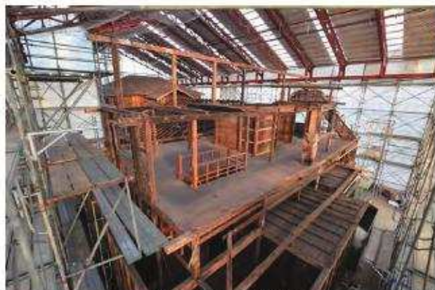
垂木解体状況 小屋組
