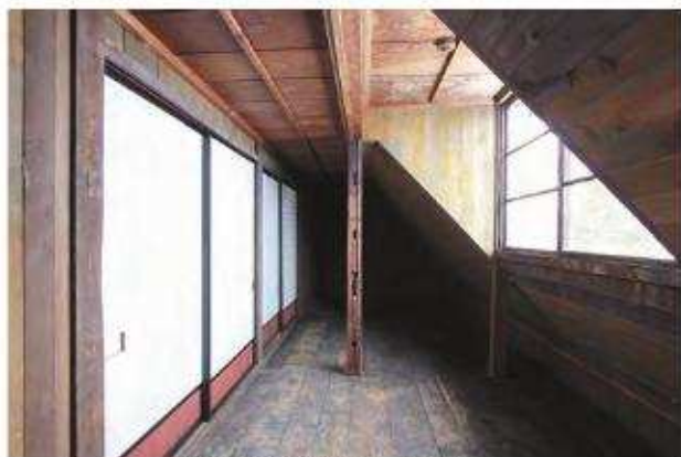
【竣工】小屋裏廊下 西よりみる
