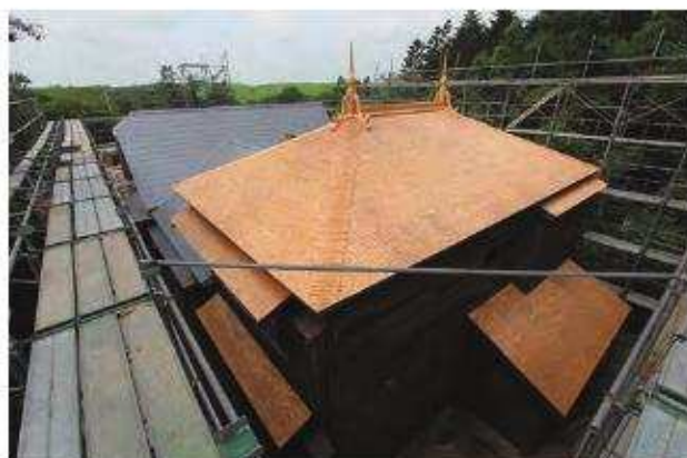
葺葺施工完了「北棟」北東よりみる
