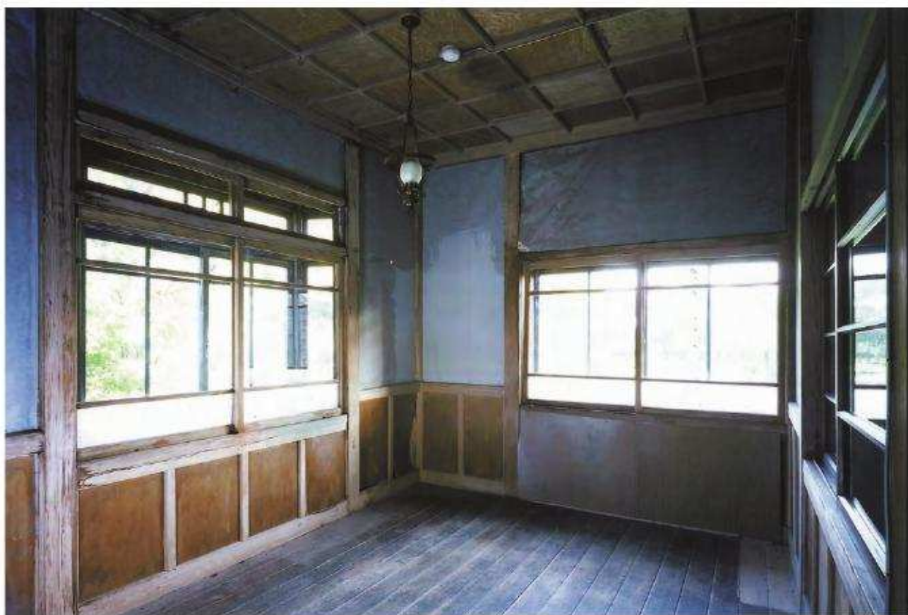
【修理前】事務所 北西よりみる
