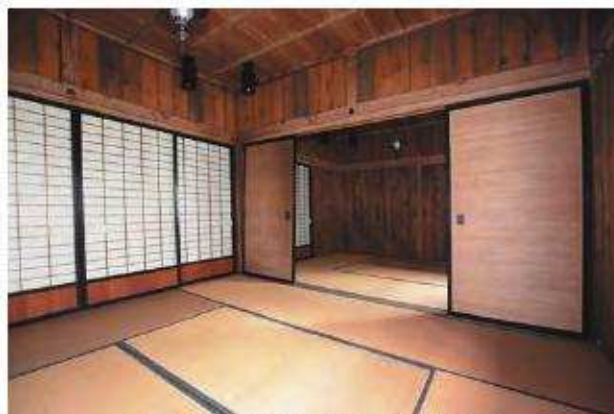
【修理前】客室7 北西より客室6を見通す
