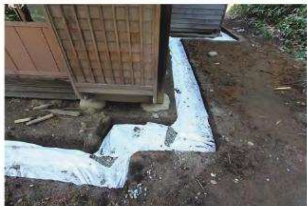
不織布透水シート施工状況
