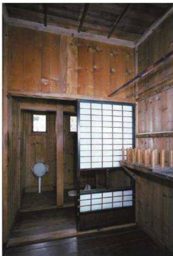
【竣工】ランプ室より便所を見通す
