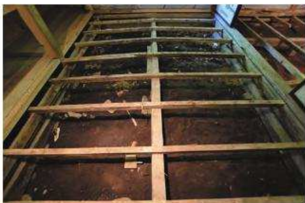
荒床解体完了 床組 客室3 東よりみる
