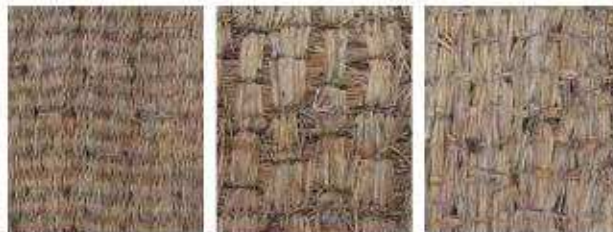
写3-5-43 南棟和室1・2 畳裏菰仕様 3種類の裏菰が使用されており、時期差があるものを寄せ集めている。
