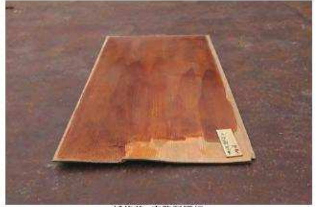
補修前 事務所腰板
