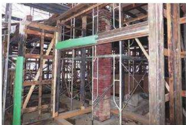
煙突施工完了
