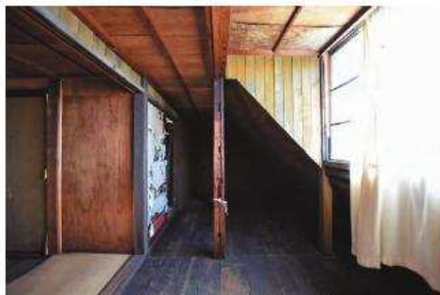
【修理前】小屋裏廊下 西よりみる
