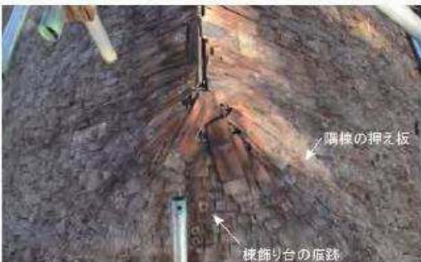
写 3-5-13 「北棟」鉄板下に遺存していた桁葺
