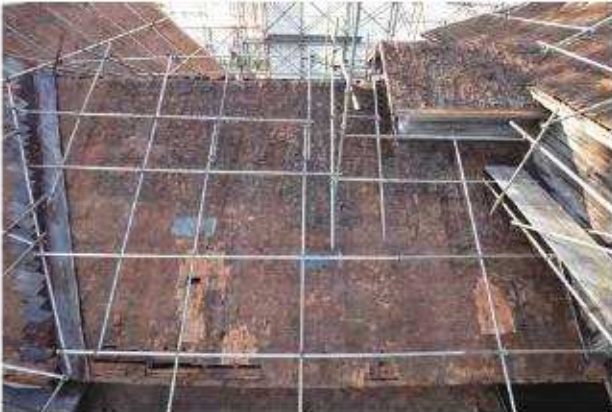
鋼板葺解体完了 東面桁葺
