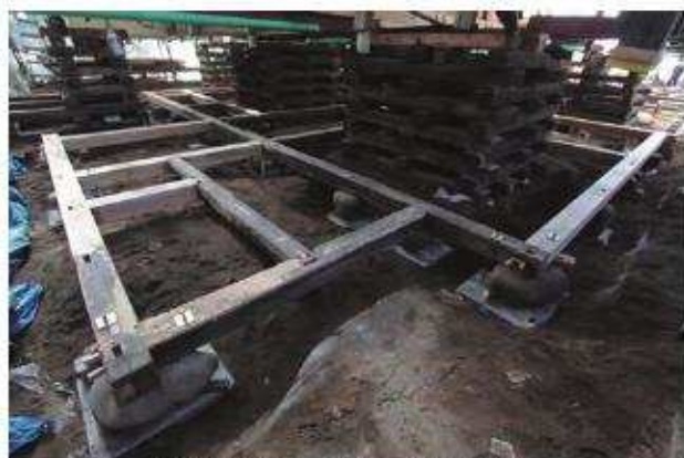
土台組立完了「北棟」北西よりみる
