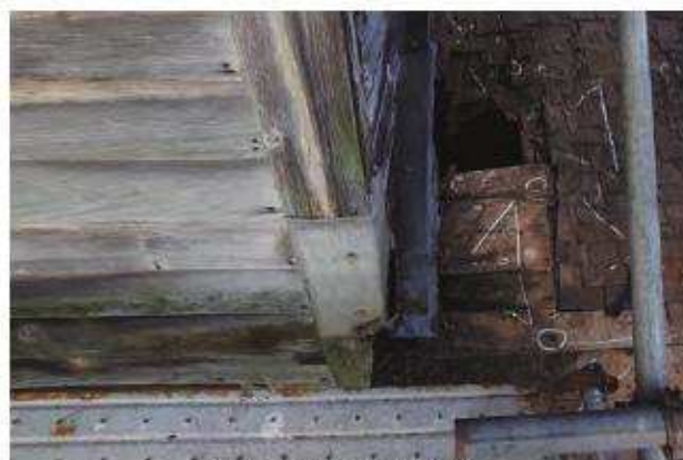
西面「北棟」壁との取合い
