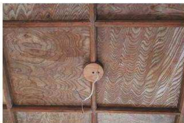
木台設置状況
