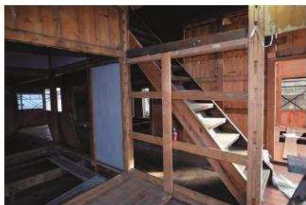
縦板張解体完了 客室2押入 南西よりみる
