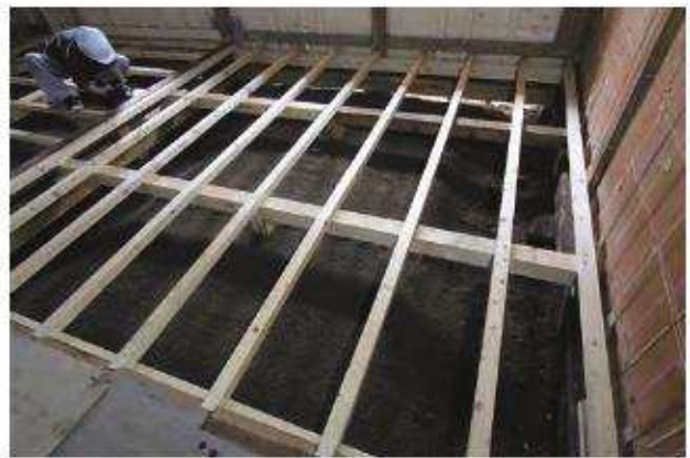
保護砂敷設状況「中央棟」客室2 東よりみる
