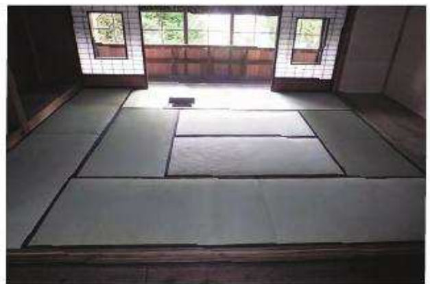
畳施工完了「北棟」客室8 西よりみる
