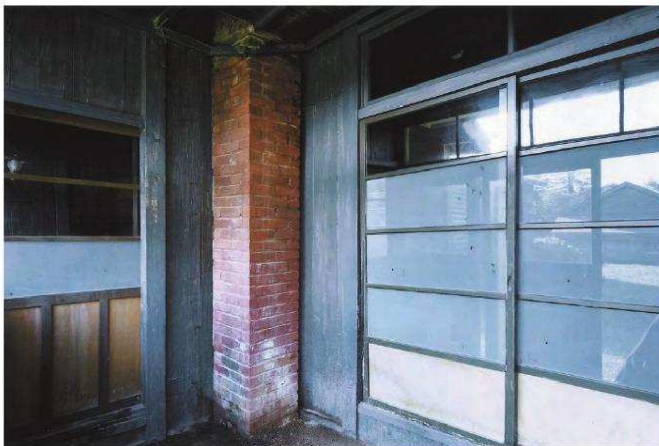
【修理前】裏玄関 南東よりみる
