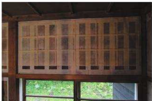
袋貼施工状況
