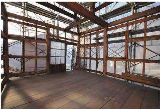
縦板張解体完了 物置 北東よりみる
