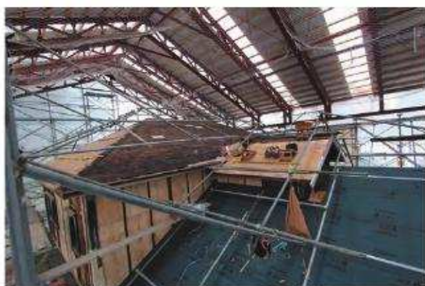
野地板施工完了「北棟」南西よりみる
