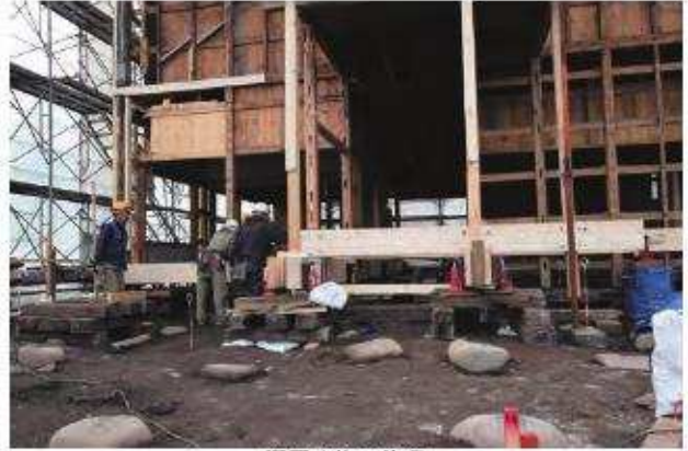
腰固め施工状況
