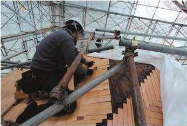
平葺施工状況
