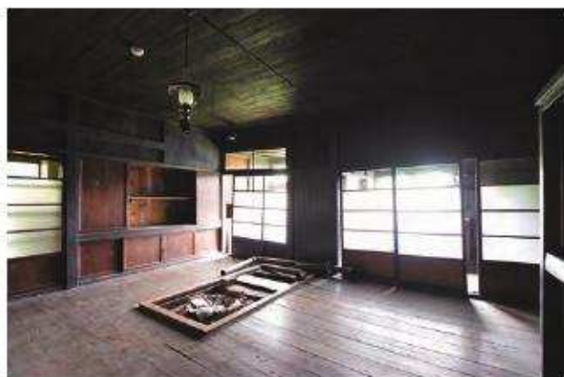
【修理前】居間 北西よりみる
