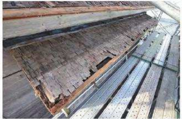
桁葺 東側庇 南東よりみる
