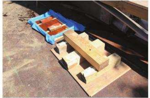
補修状況 事務所腰板
