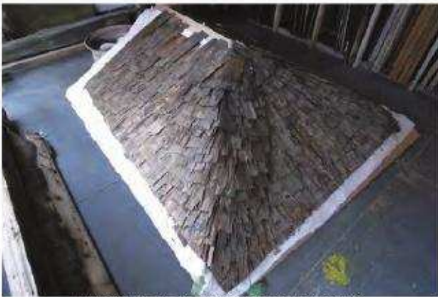
解体時に大バラシした棟飾り痕跡部分の桁葺
