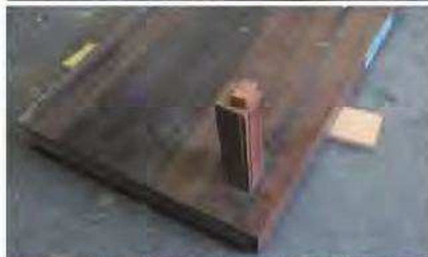
写3-5-8 仏間床脇違い棚（上：上段 下：下段）と筆返背面（右上）樹種はカツラであったが表面に黒い筋をいれた唐木風の木目を描いている。
