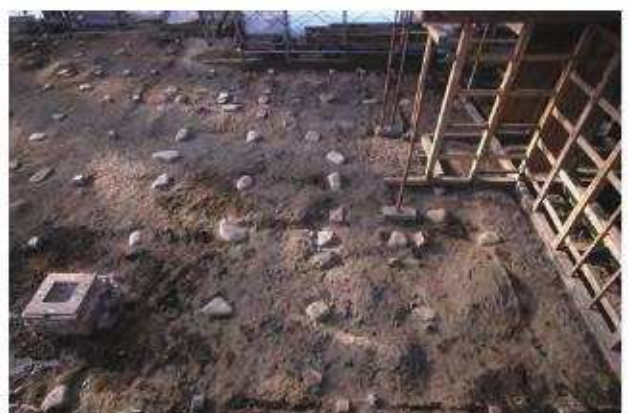
土台解体完了 礎石
