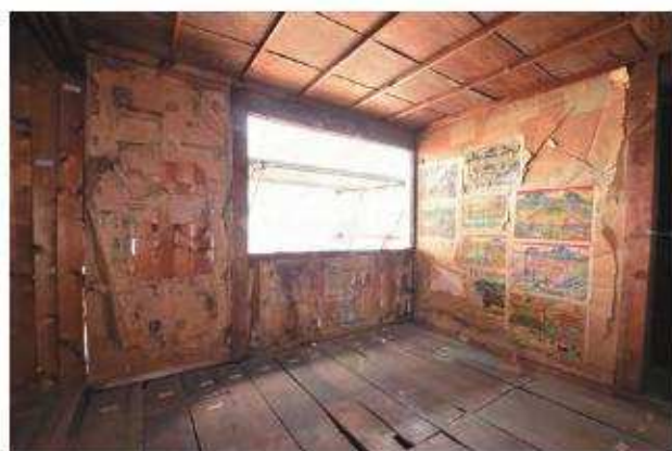
【修理前】和室2 北西よりみる
