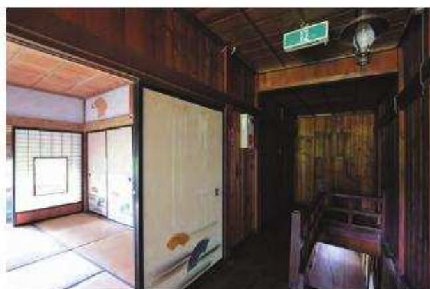
【修理前】「北棟」二階廊下 北西よりみる
