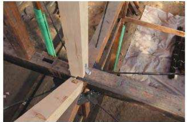
水平ブレース取付詳細
