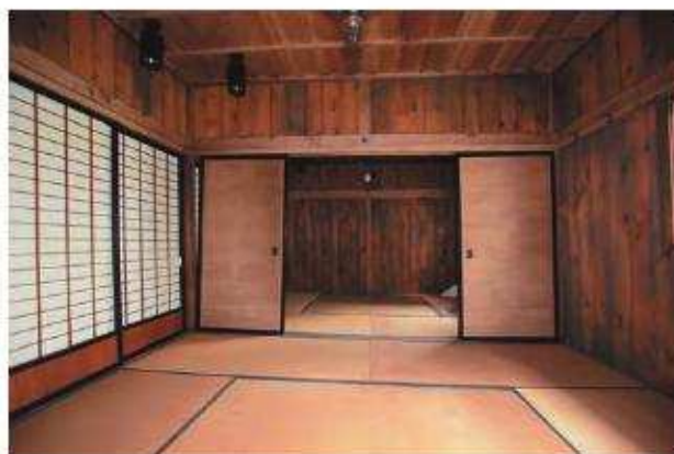
【修理前】客室7より客室6を見通す
