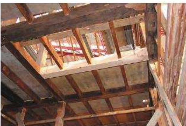
構造補強梁設置状況
