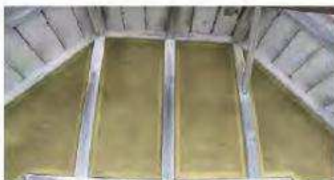
写 3-5-19 「南棟」掃付けモルタル壁
