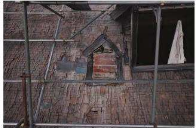
煙突の屋根突出部取付状況
