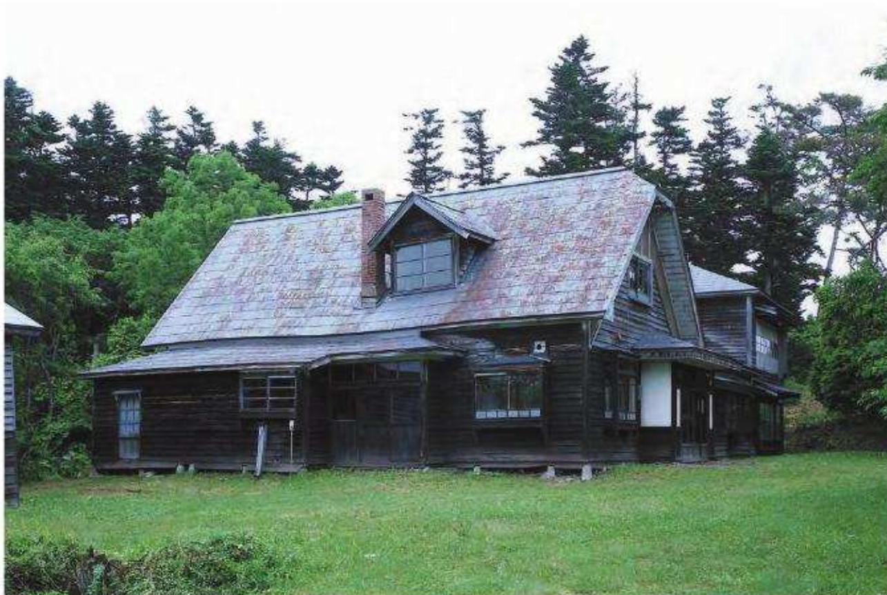
【修理前】外観 南東よりみる
