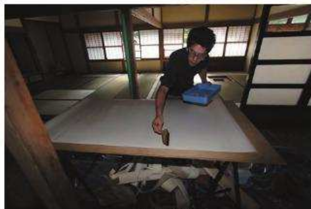
上貼作業状況
