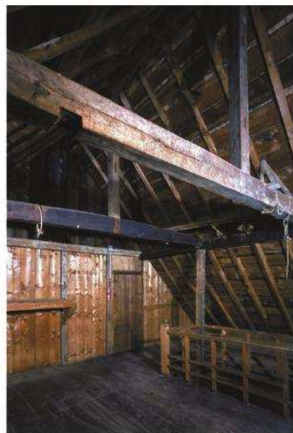
【修理前】小屋裏物置 北西よりみる
