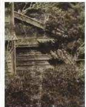
中古の改造を受けた洗面所（昭和初期） 妻壁に底を設け張り出している様子がうかがえる。壁面に窓はなく板張りである。
