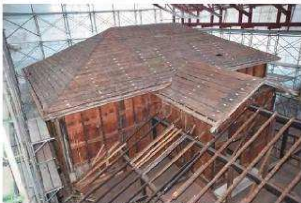
桁葺解体完了 野地板
