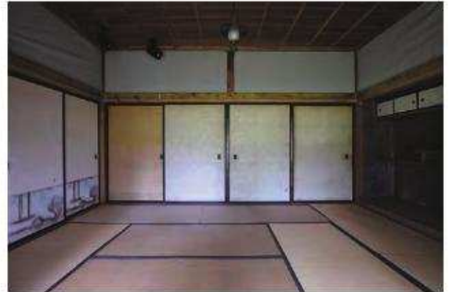
【修理前】客室5 東よりみる
