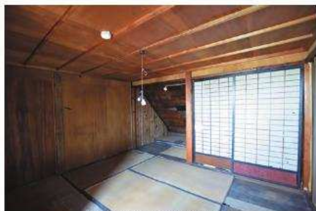
【修理前】和室1 南東よりみる
