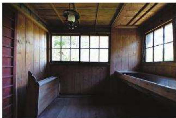
【修理前】「北棟」洗面所 南よりみる
