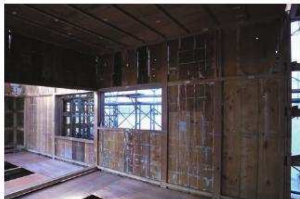
紙貼解体完了 客室2北東よりみる
