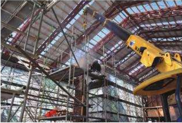
煙突解体状況
