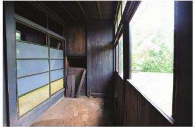
【修理前】裏玄関 西よりみる
