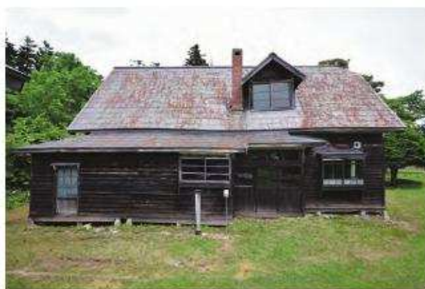
【修理前】「南棟」南面
