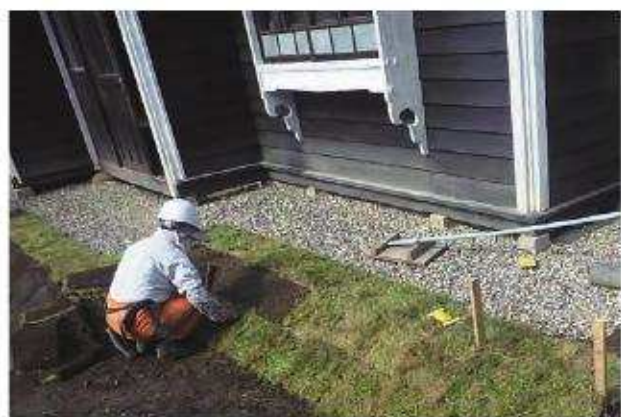
法面芝張施工状況
