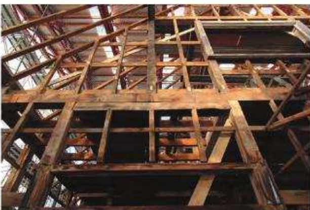
壁下地組立完了「南棟」東よりみる
