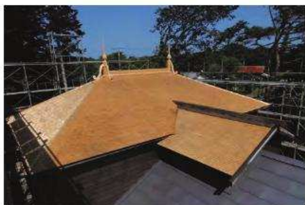
葺葺施工完了「北棟」南西よりみる
