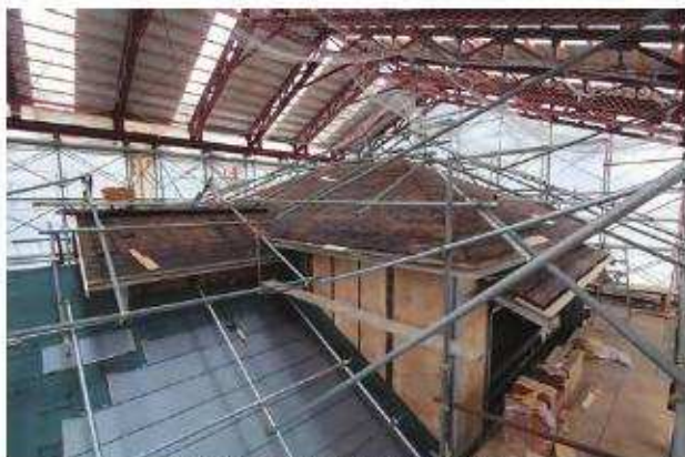
野地板施工完了「北棟」南東よりみる
