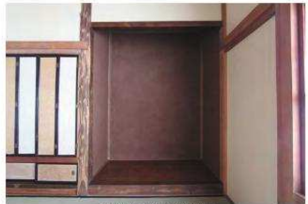
鋸屑壁施工完了 仏間トコ
