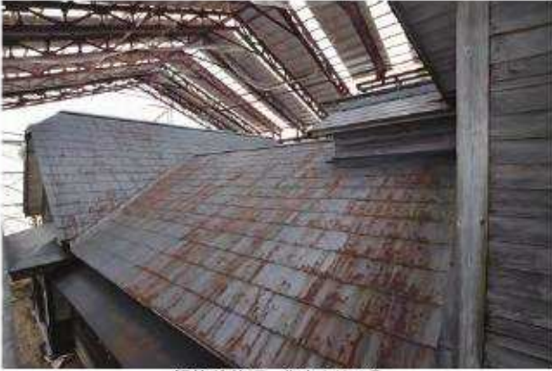
解体前状況 北東よりみる
