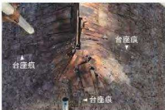
葺葺に残る棟飾り蕨手台座痕（西側） 鉄板の下に当初の葺葺が遺存しており、棟の東西端部に蕨手状脚部の台座痕が三方にあった。
