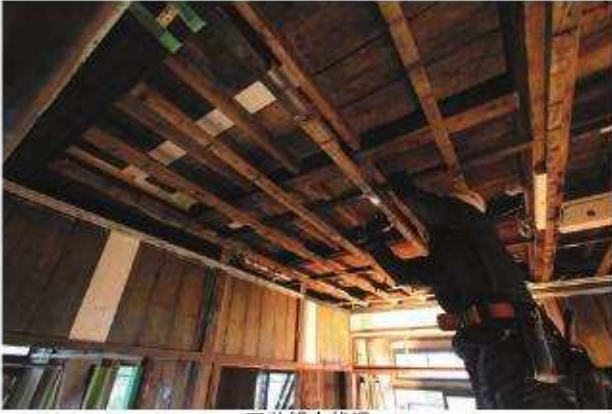
天井組立状況
