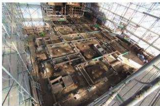
土台組立完了 南西よりみる
