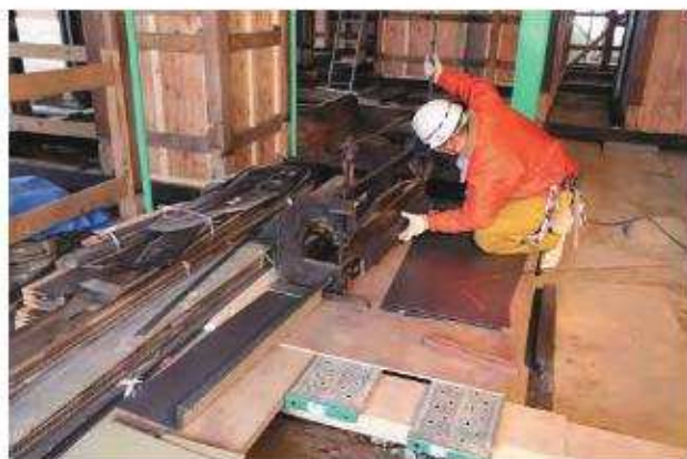
板金加工状況
