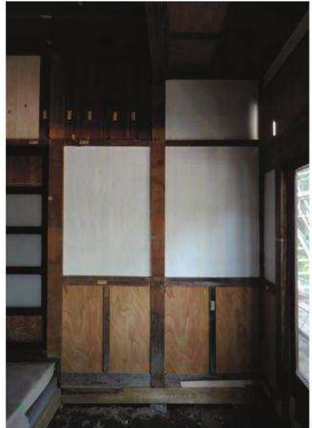
漆喰壁施工完了 玄関
