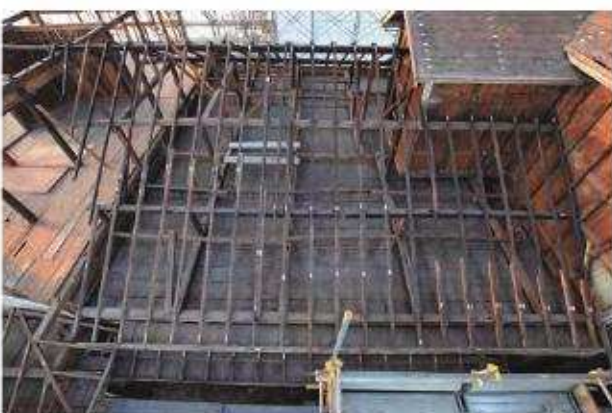
野地板解体完了 垂木
