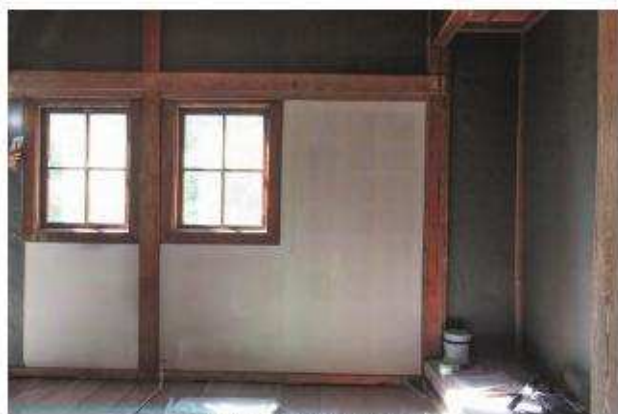
袋貼完了「北棟」客室7
