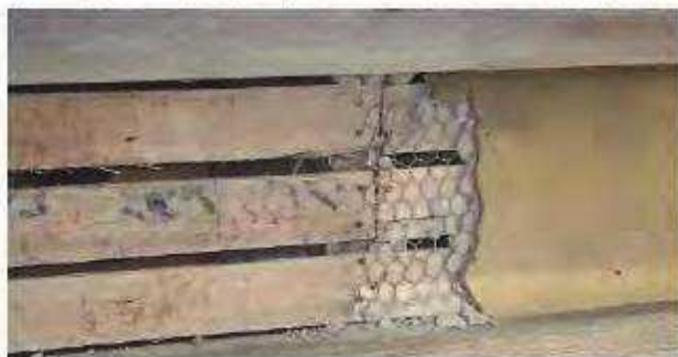
写 3-5-21 「中央棟」セメント壁解体時状況
