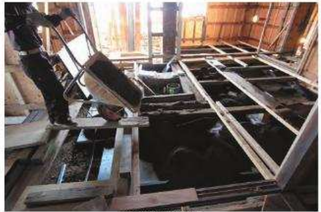
保護砂敷設状況
