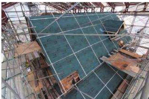
ルーフィング下地施工完了「南棟」南西よりみる
