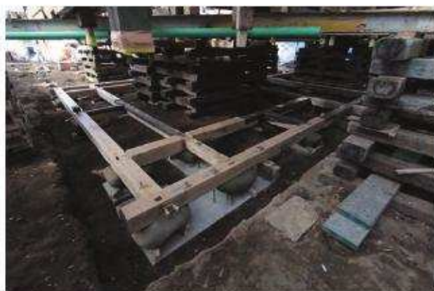
土台組立完了「北棟」北東よりみる
