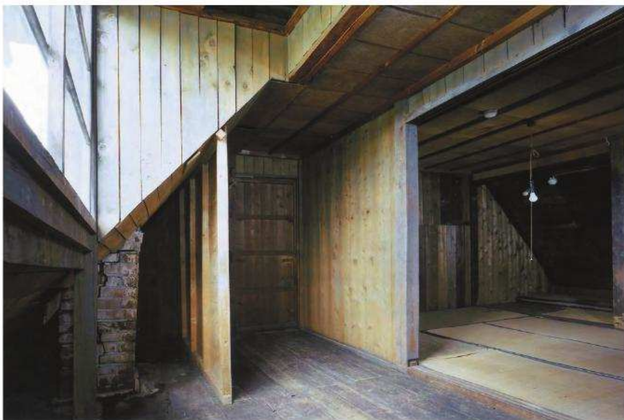
【修理前】小屋裏廊下南東より和室1を見通す
