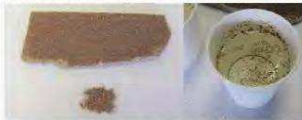
写 3-5-23 鋸屑壁調査状況 （左：解体壁部分、右：構成材料の確認）
