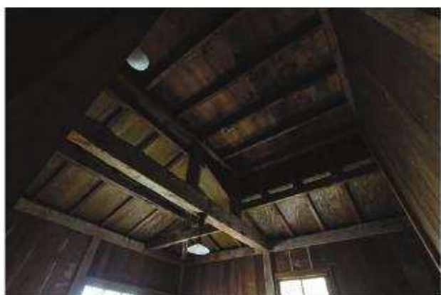
【竣工】 物置 小屋現わし天井
