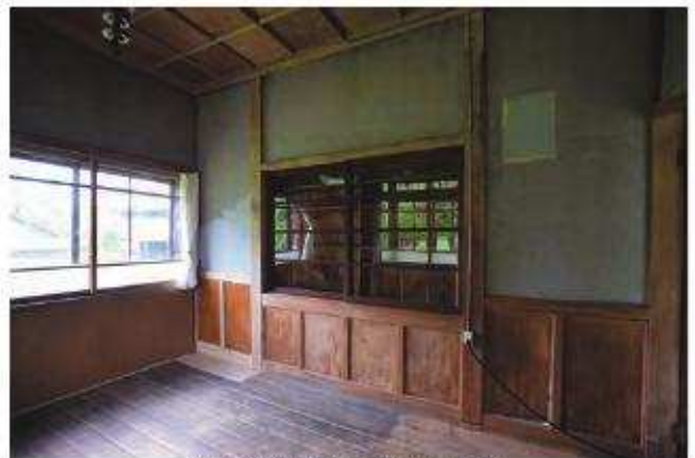
【修理前】事務所 北東よりみる
