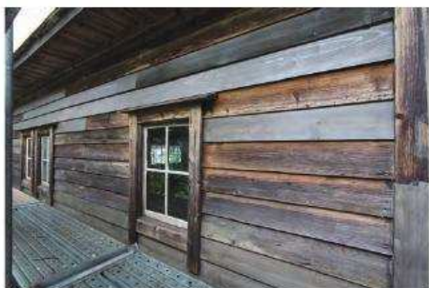
古色塗り完了「北棟」二階 西面
