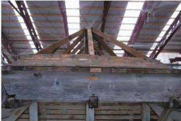
東側妻面頂部垂木
