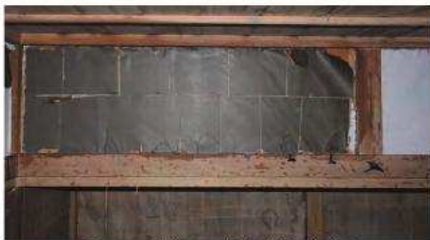
写3-5-36 遺存していた当初壁紙（客室8）
