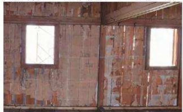
写3-5-39 客室6（左）と客室7（右）の下貼り遺存状況 客室7はこれまでに2回下貼りの袋貼を撤去した痕跡があり、客室6は最初の貼り替え時に重ねて貼られたため下貼りの残存状況がいい。
