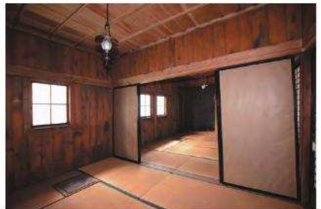
【修理前】客室6 南東より客室7を見通す
