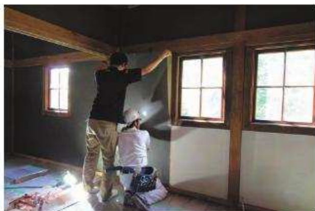
上貼施工状況
