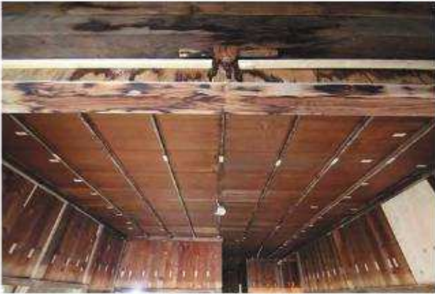
天井組立完了「南棟」玄関、廊下 東よりみる
