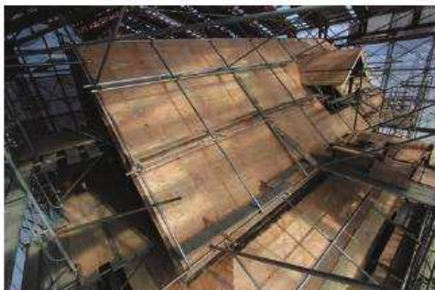
野地板施工完了「南棟」南西よりみる
