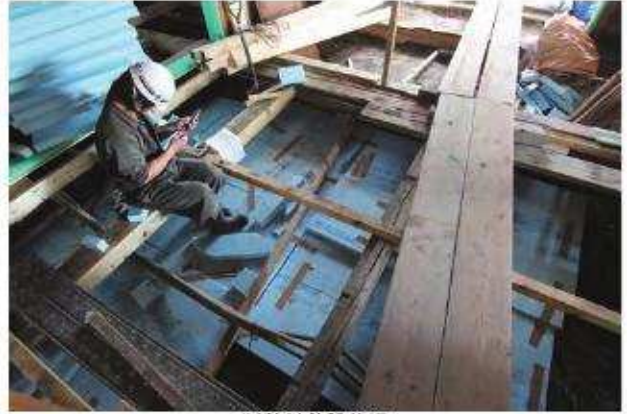
断熱材敷設状況
