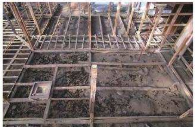
軸組解体完了 土台
