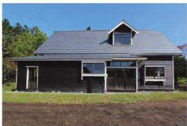
【竣工】「南棟」南面
