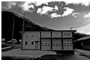
25 調査後現況 (西から)
